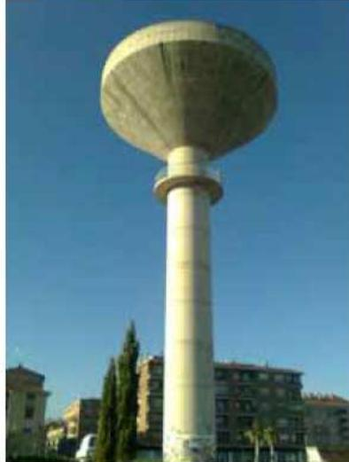
Tiene un volumen de 1.000 m<sup>3</sup> y es de un solo vaso. Así, la función de este depósito es que el agua gane altura y así abastecer con presión suficiente a todos los puntos del municipio.
