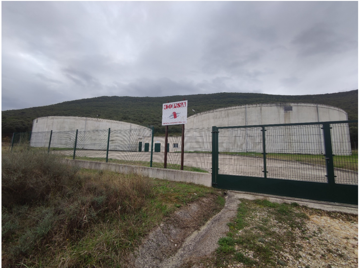
Depósitos y captación de La Calera
