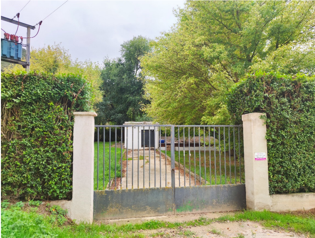
Captación de Valverde de Miranda
