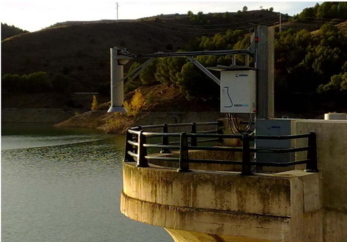
Sonda Aquadam instalada en el embalse de La Tranquera
