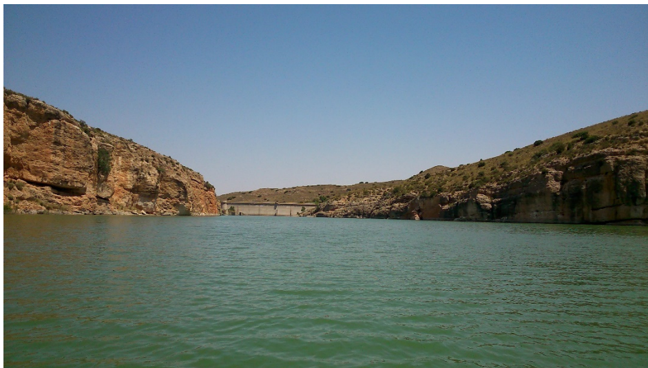
Figura 7. Vista de la presa del embalse
