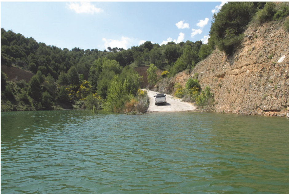
Figura 10. Vista del punto de acceso.
