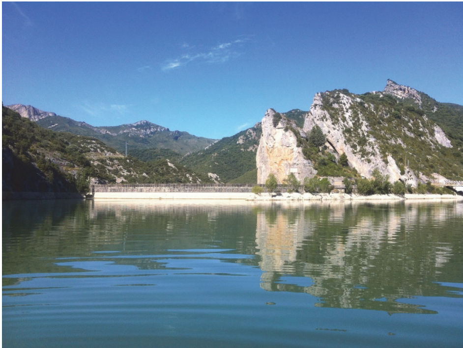
Figura 7. Vista de la presa del embalse
