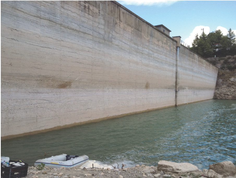
Figura 7: Vista de la presa del embalse
