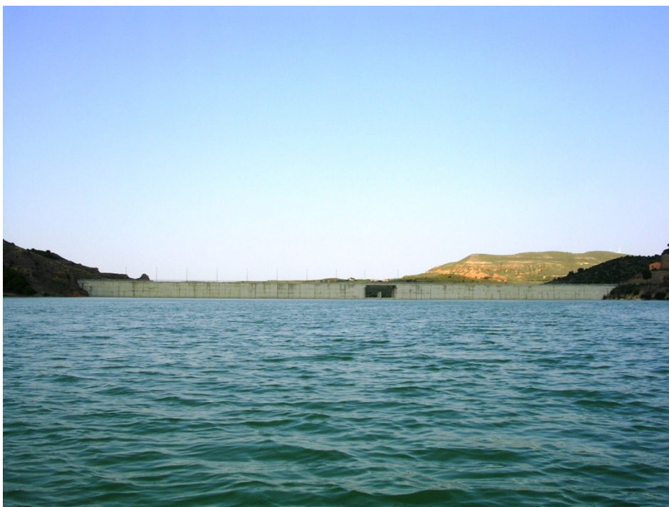
Figura 7. Vista de la presa del embalse.
