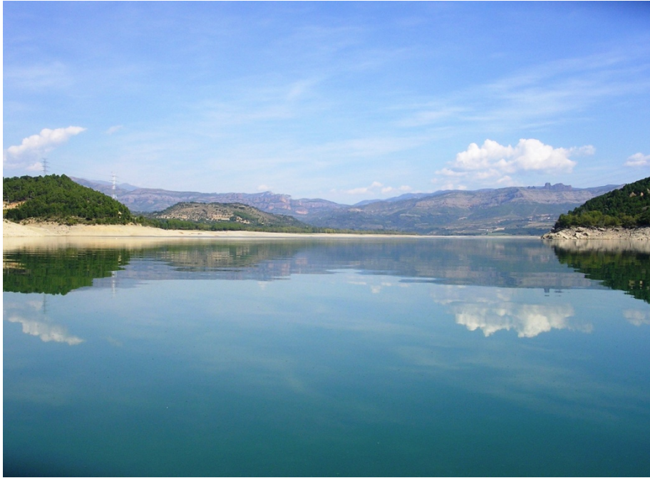
Figura 9. Vista de la cola del embalse
