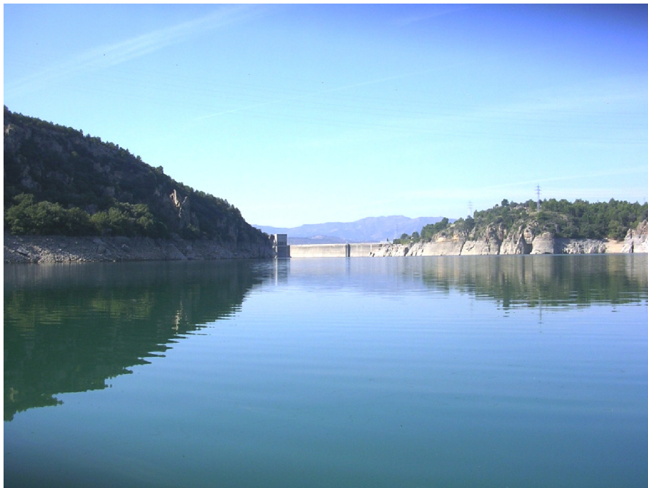
Figura 7. Vista de la presa del embalse
