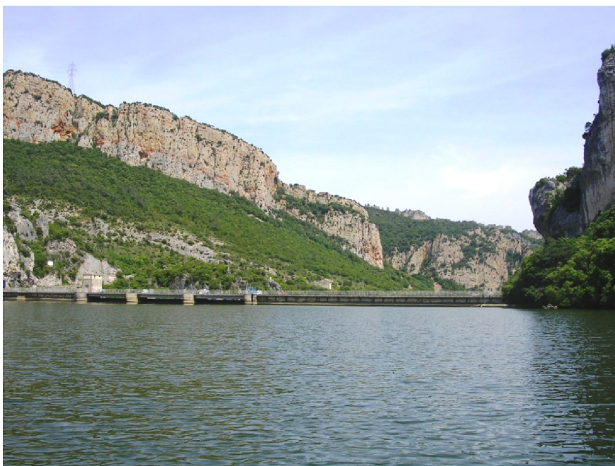
Figura 7. Vista de la presa del embalse
