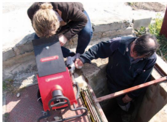
■ FIGURA 7.4.b INSPECCIÓN DE UNA TUBERÍA CON LA CÁMARA ENDOSCÓPICA.
