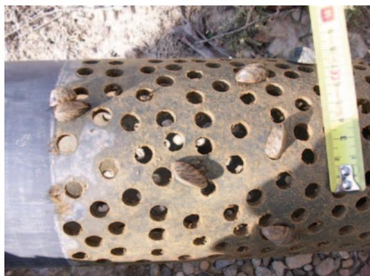
■ FIGURA 7.4.a FILTRO DEL INTERIOR DE UNA TUBERÍA AFECTADA POR MEJILLÓN CEBRA.
