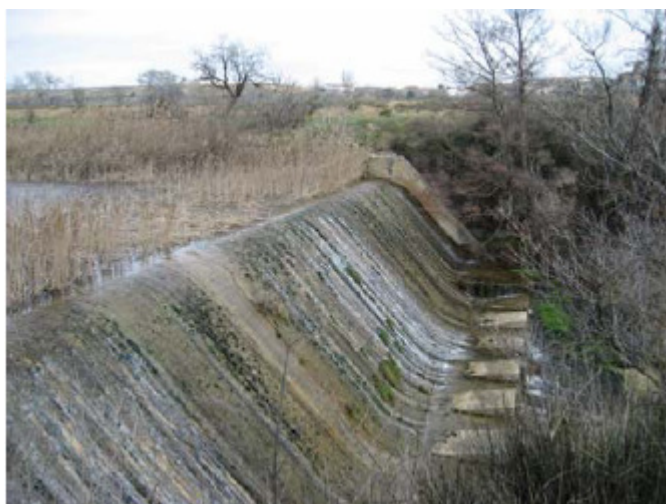
Azud de la acequia de Argavieso utilizada para riego y que nace en la margen izquierda del río Guatizalema a su paso por la localidad del Pueyo de Fañanás. No hay escala de peces. Este azud se apoya sobre un salto natural.
