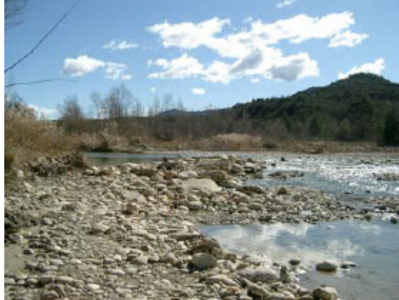
Azud de derivación para riego construido con los materiales del propio cauce
