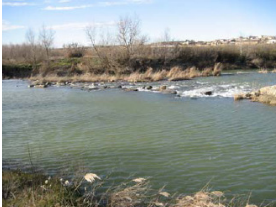
Vista general del azud de la acequia de Ontiñena.
