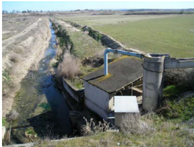
Desagüe D-78 de retornos de riego que desemboca en el río Flumen, con una estación de bombeo para reutilizar el agua. Este desagüe suele llevar mucha agua. Este es un antiguo barranco que ahora se ha convertido en desagüe.
