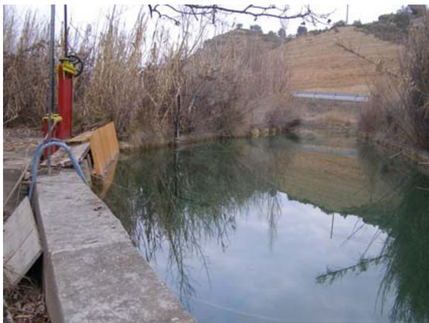
C.H. de Huerta de Vero. Cámara de carga.
