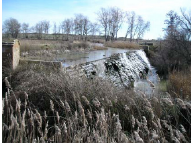
Vista general del azud de la acequia de Buñales para riego.
