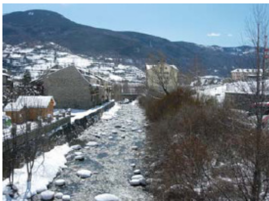
Canalización del Ésera a su paso por la población de Benasque.
