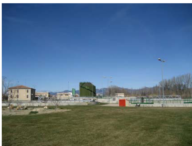
Depuradora de Huesca junto al río Isuela, aguas abajo de dicha localidad.
