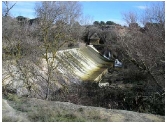
Azud de la acequia de Barbués aguas arriba de dicha localidad.
