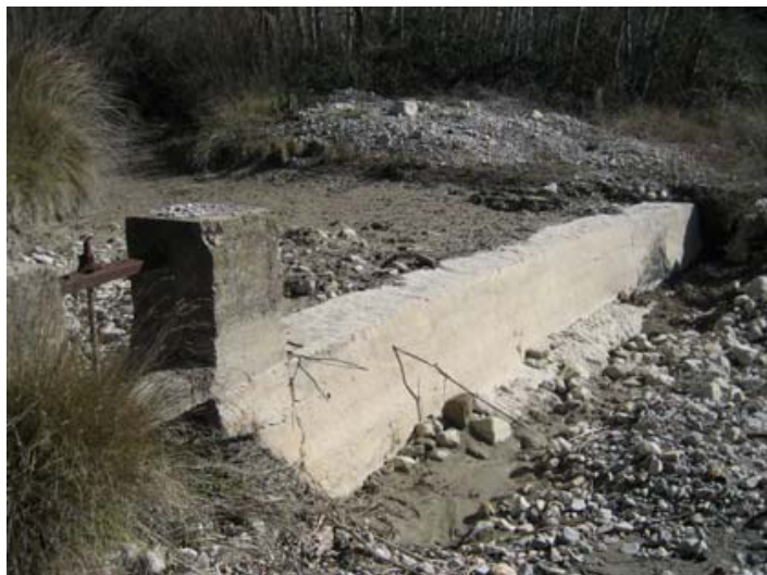
Vista general del azud de Arascués, situado en el río Isuela aguas abajo de la localidad de Nueno, donde nace la acequia madre de los regantes del embalse de Arguís. En este tramo el río Isuela está seco debido a la infiltración de agua al ser una zona de abundantes gravas.
