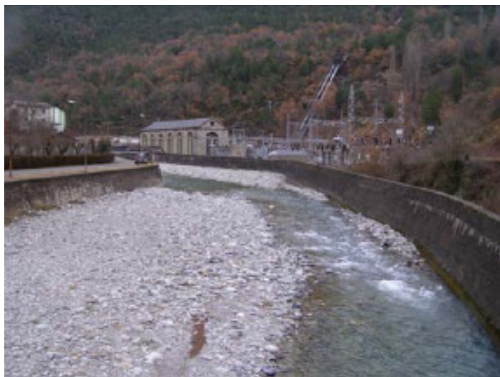
Central Hidroeléctrica de Lafortunada. Río Cinca a su paso por Lafortunada. Las dos tuberías derivan agua desde el embalse de Pineta y desde el embalse de Plandescún.
