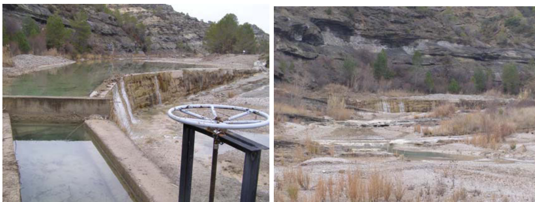
Azud en el río Susía para riego al municipio de Abizanda, aguas arriba de la E.A. 257 Susía en Escanilla.
