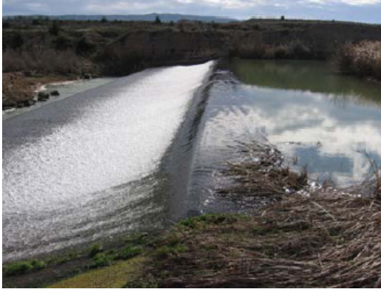
Vista del azud de la acequia de Sena en el río Alcanadre aguas arriba de dicha localidad. No tiene escala de peces.
