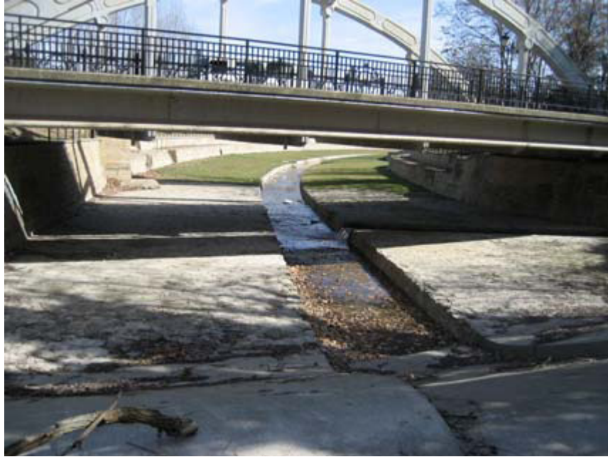
Vista general de la canalización del río Isuela a su paso por la localidad de Huesca.
