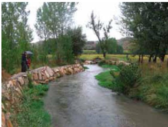
Obras de protección del cauce cerca de un azud aguas abajo de Luco de Jiloca
