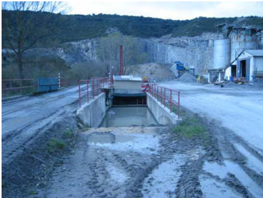
Balsa de decantación de la Cantera de Trespuentes que no funciona correctamente
