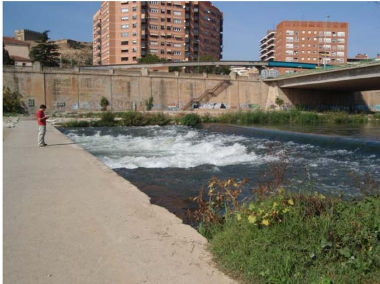
Tramo final de la canalización de Lleida. Se observa un azud con un encauzamiento del agua por debajo de una pasarela de hormigón con aliviaderos.
