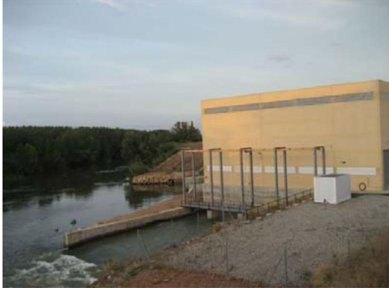
CH de Aitona en la margen izquierda del Segre. Se turbinan el agua del canal de descarga de la CH de Serós
