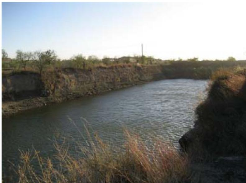
Balsa en el propio cauce del río Corp aguas abajo de la localidad de Belianes de la CR de Belianes. Se llena con agua del Canal de Urgell mediante elevación para riegos por gravedad.
