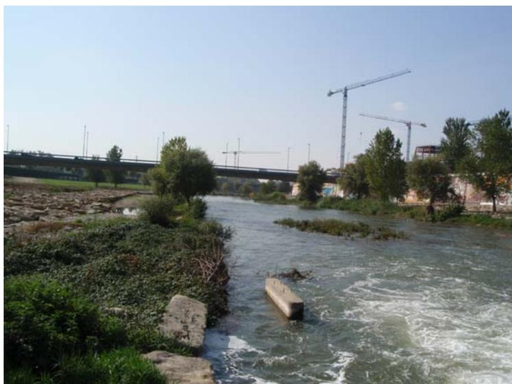
Inicio del tramo canalizado. Se observa una escollera en la zona inundable en la margen izquierda y la protección en la margen derecha.
