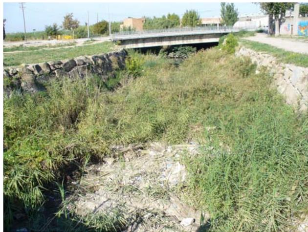
Imagen tomada desde un puente a otro a la salida de Tàrrega. El cauce está totalmente colmatado por la vegetación y el fango.
