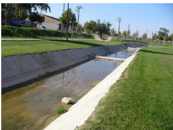
Detalle del encauzamiento del Cervera en Tàrrrega. Se ha construido una zona de recreo en ambas márgenes. Los resaltes para mantener la lámina de agua se han tenido que romper porque se colmataban de sedimentos.
