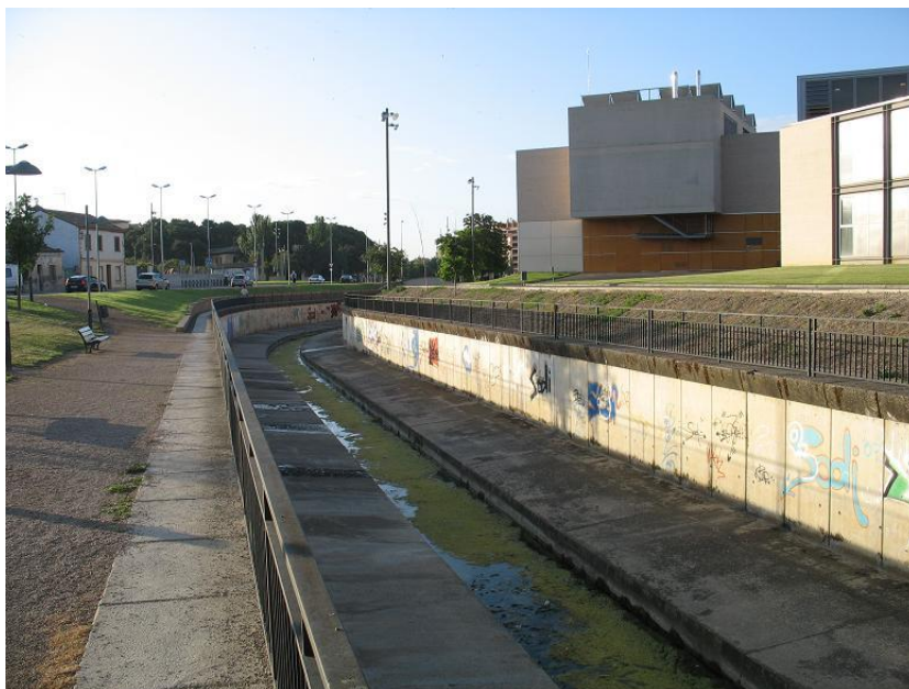
Figura 27-5. Cauce canalizado del río Isuela en la ciudad de Huesca.
