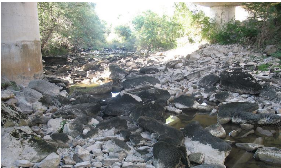
Figura 6-9. Cauce del río Bayas en su intersección con la autopista AP-1.
