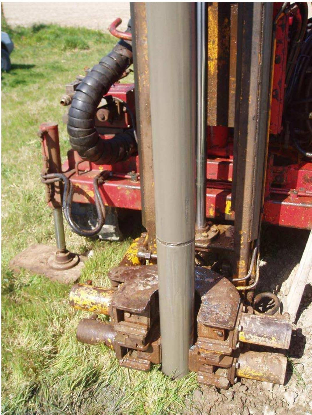
Figura 3.20. Perforación de los piezómetros a destroza, piezómetro Pz5.
