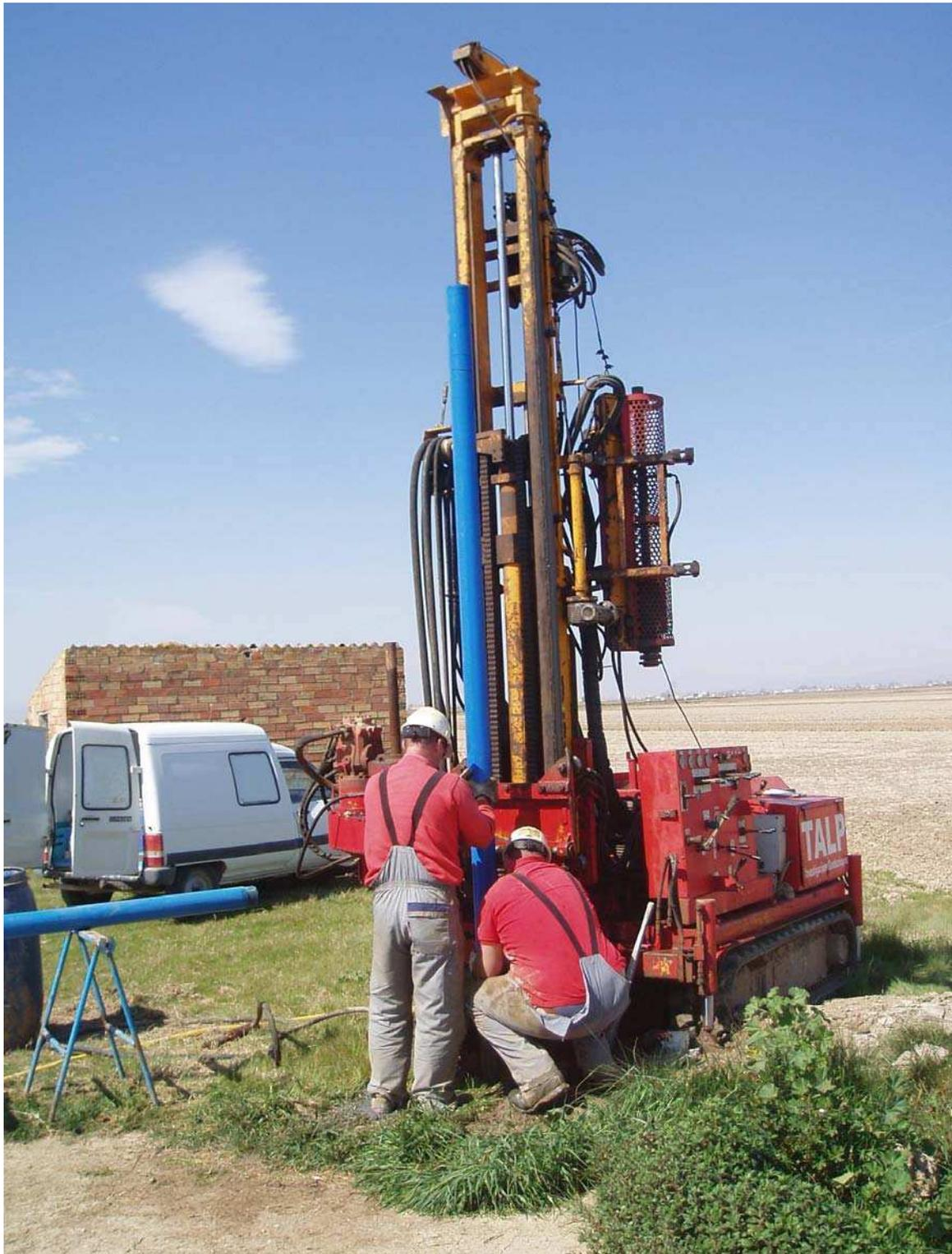
Figura 3.21. Colocación del tubo de PVC de 4", piezómetro Pz5.
