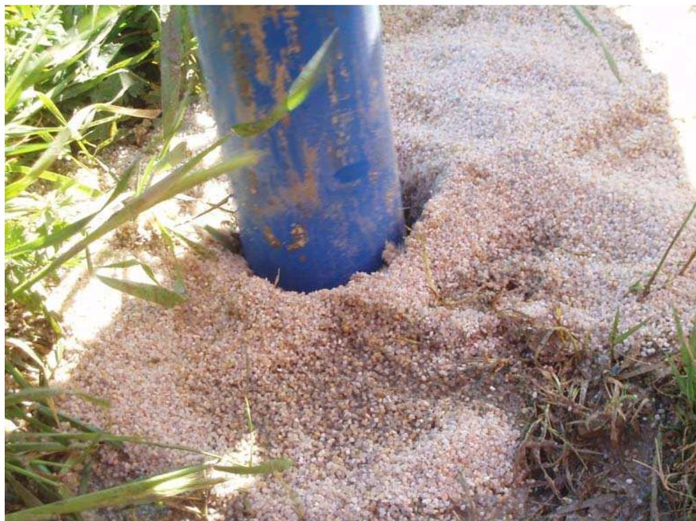
Figura 3.23. Grava silíceica de 2.5 mm, colocada a modo de prefiltro.
