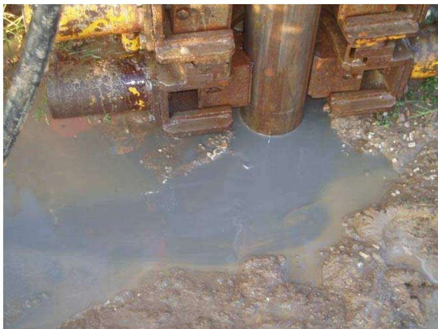
Figura 3.3. Detalle del material excavado a partir de los primeros metros en el piezómetro Pz2 (gris), junto al material excavado en los primeros metros (marrón).
