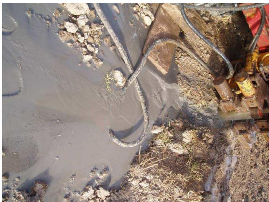
Figura 3.15. Detalle del material excavado a partir de los primeros metros en el piezómetro Pz10.
