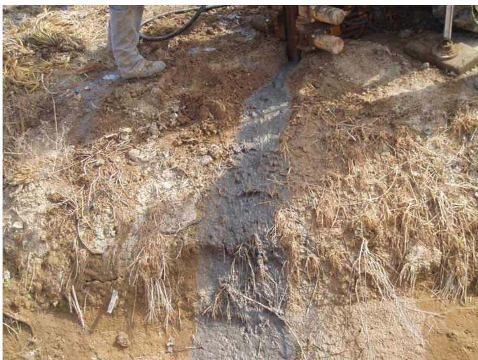
Figura 3.19. Detalle del material excavado a partir de los primeros metros en el piezómetro Pz11.
