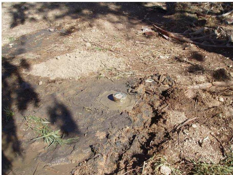
Figura 3.25. Piezómetro Pz8 finalizado.
