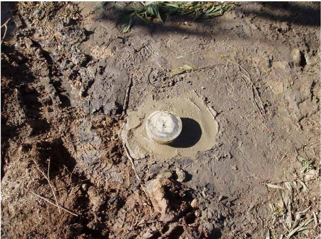
Figura 3.6. Piezómetro Pz8 finalizado.
