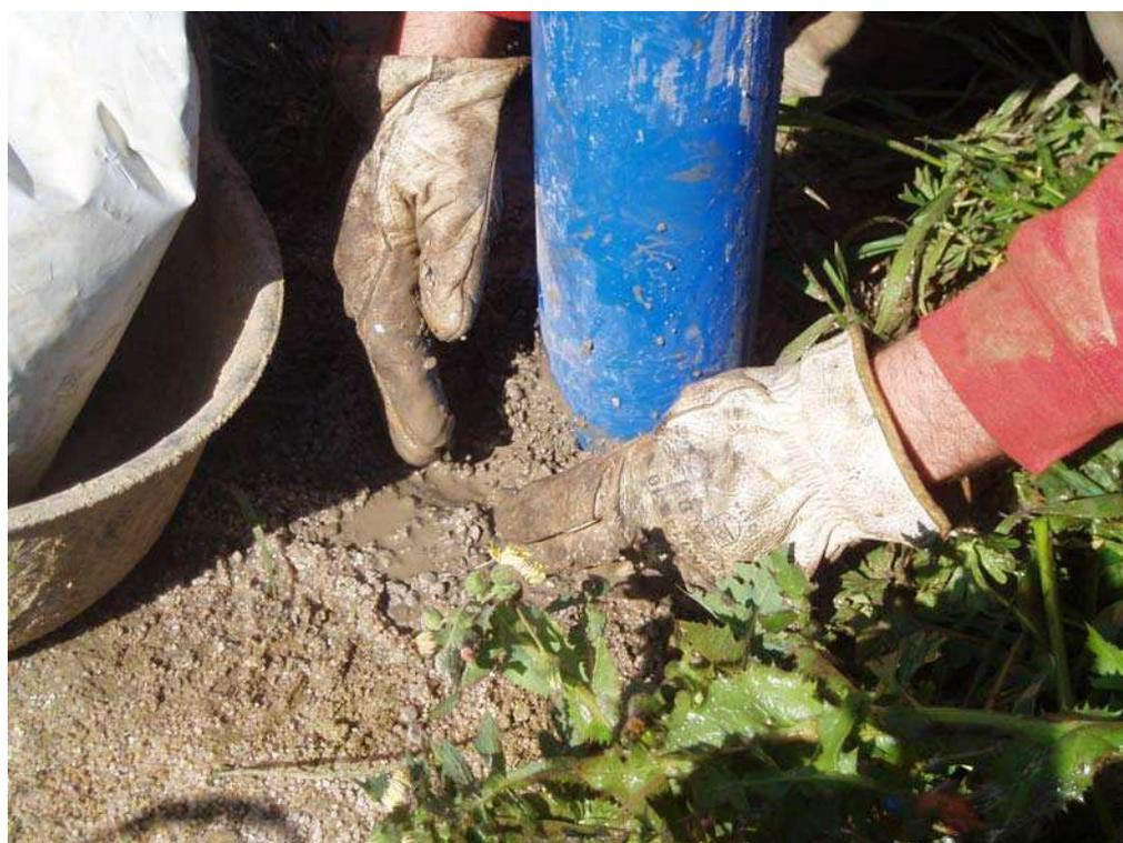
Figura 3.24. Colocación de pellets para el sellado del piezómetro.
