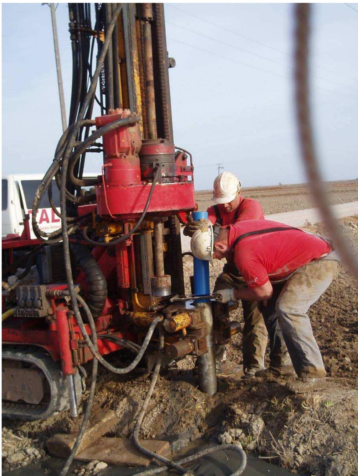
Figura 3.22. Finalización del entubado, piezómetro Pz9.
