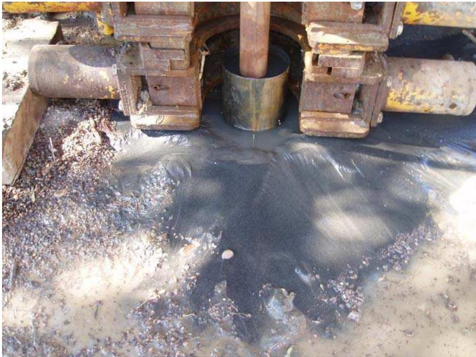
Figura 3.12. Detalle del material excavado a partir de los primeros metros en el piezómetro Pz8.
