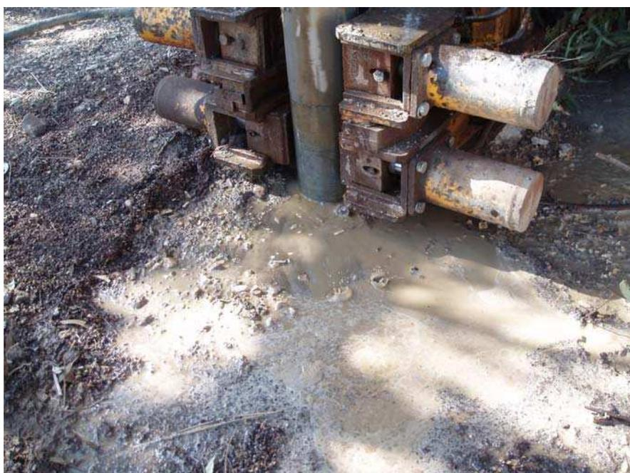
Figura 3.11. Detalle del material excavado durante los primeros metros en el piezómetro Pz8.
