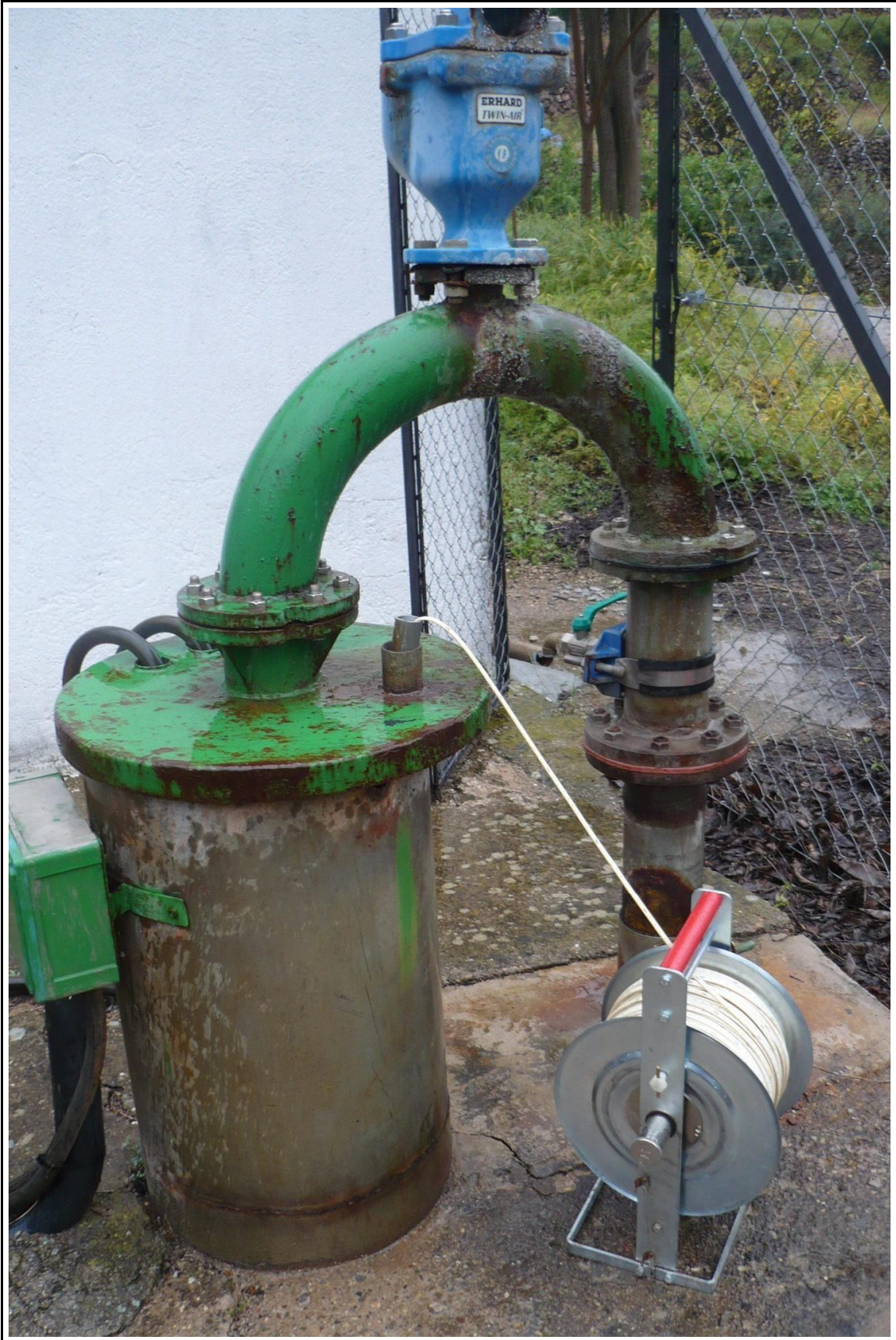
Detalle Del Pozo (03/05/2009)
