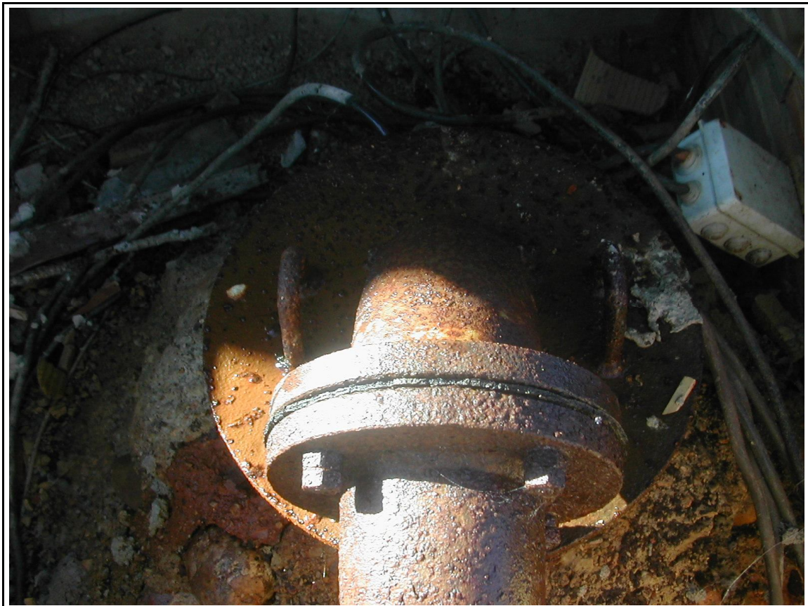
Vista de detalle 1 (14/11/2006)
