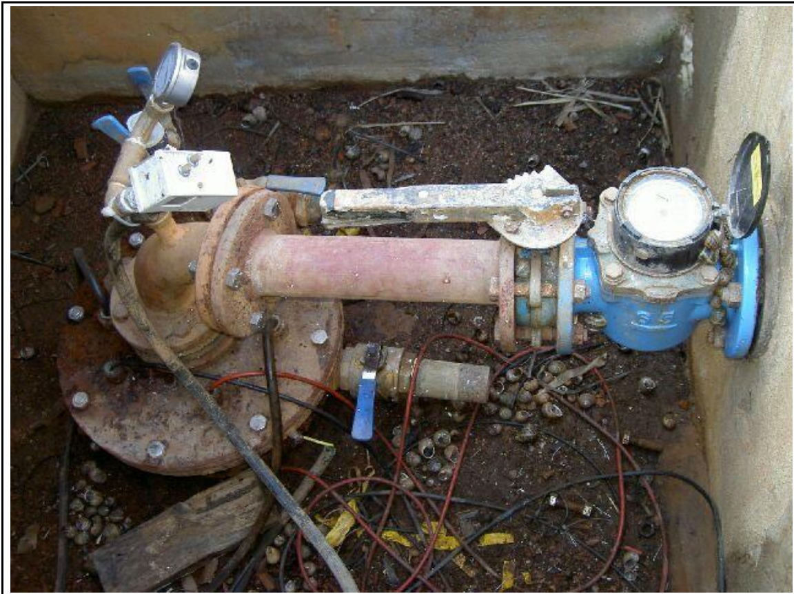
Vinebre.Pou Val des Horts.detalle pozo (Inv. abastec. Importada automáticamente) (01/01/2008)
