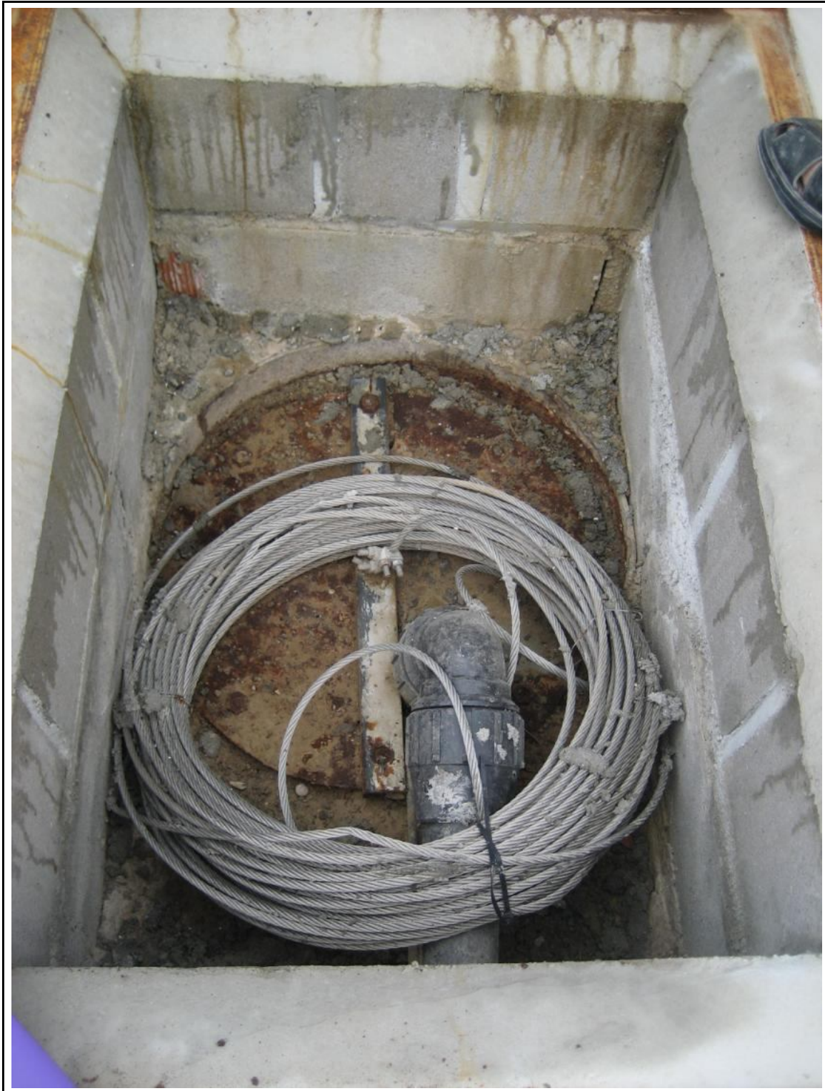
Pozo del lavadero de la Torre de l'Espanyol (08/07/2008)
