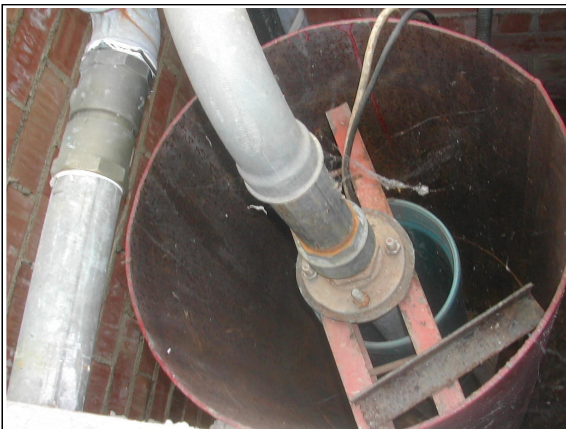
Vista de detalle (16/11/2006)
