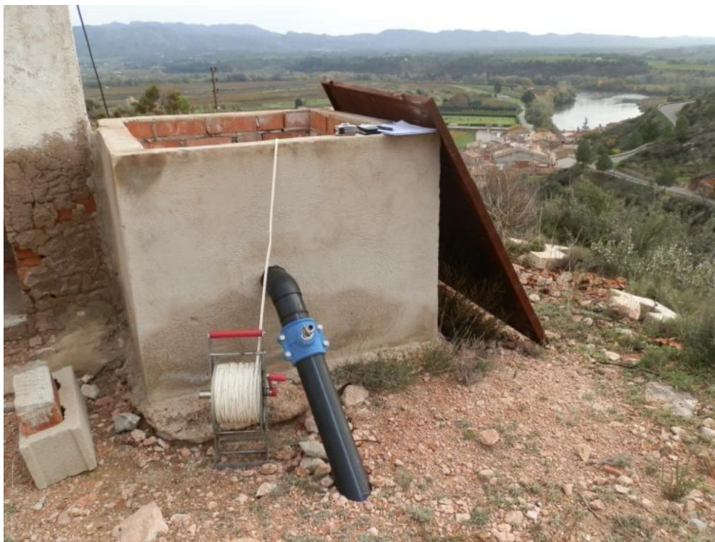
Foto 1. Situación pozo abastecimiento Miravet
