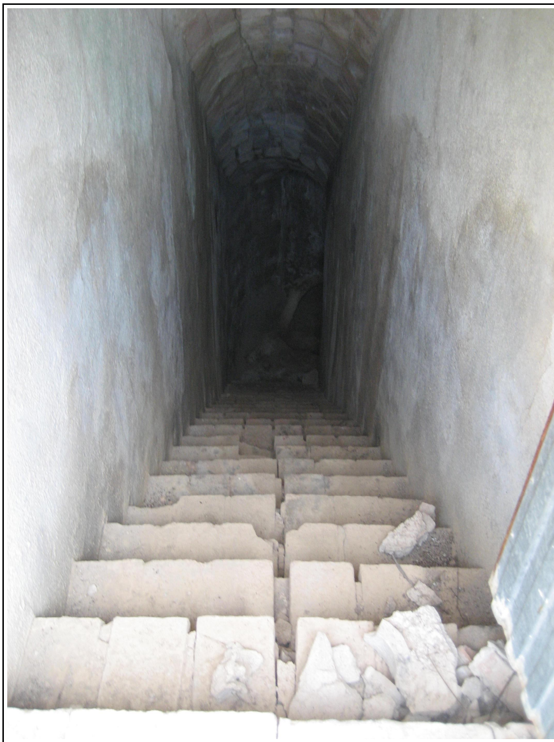
Interior de la mina del manantial Aguas de Broi (08/07/2008)
