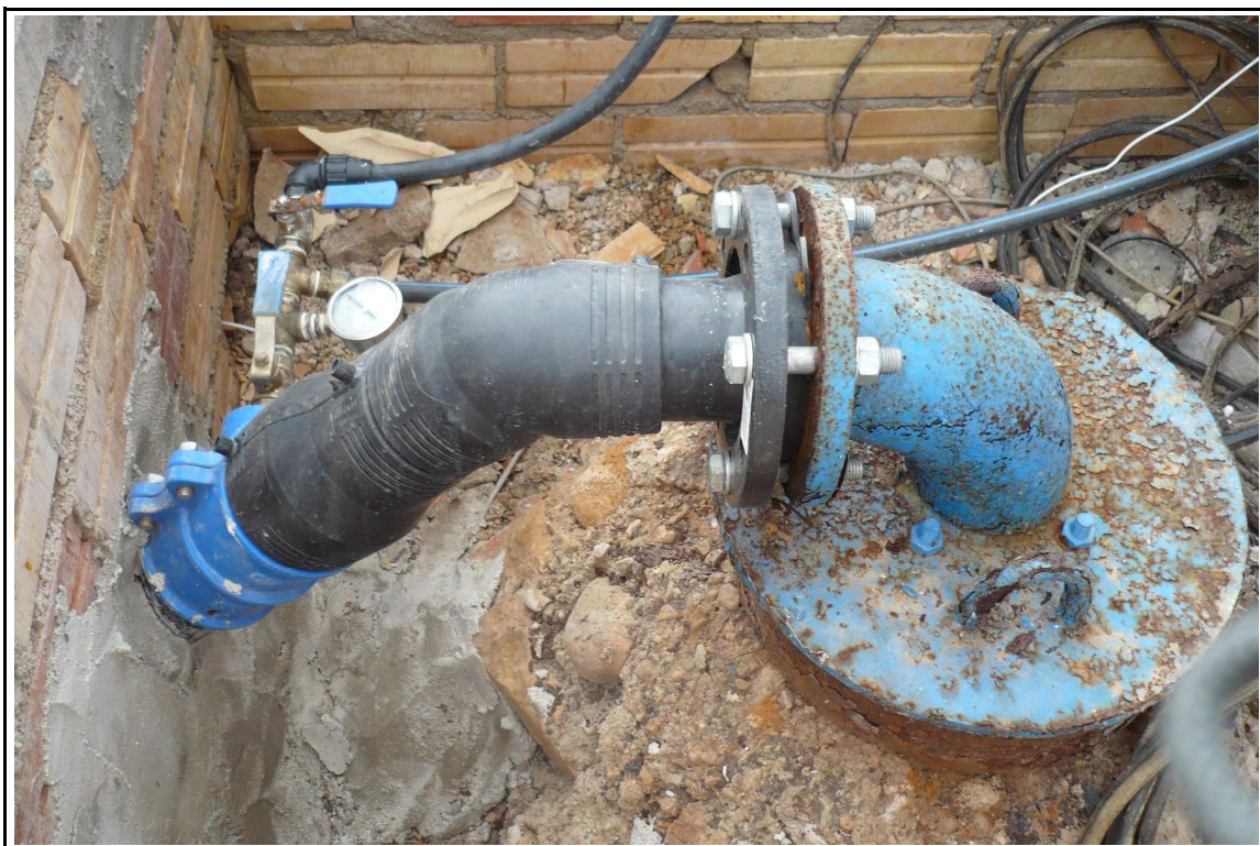
Detalle Del Pozo 2 (04/05/2009)
