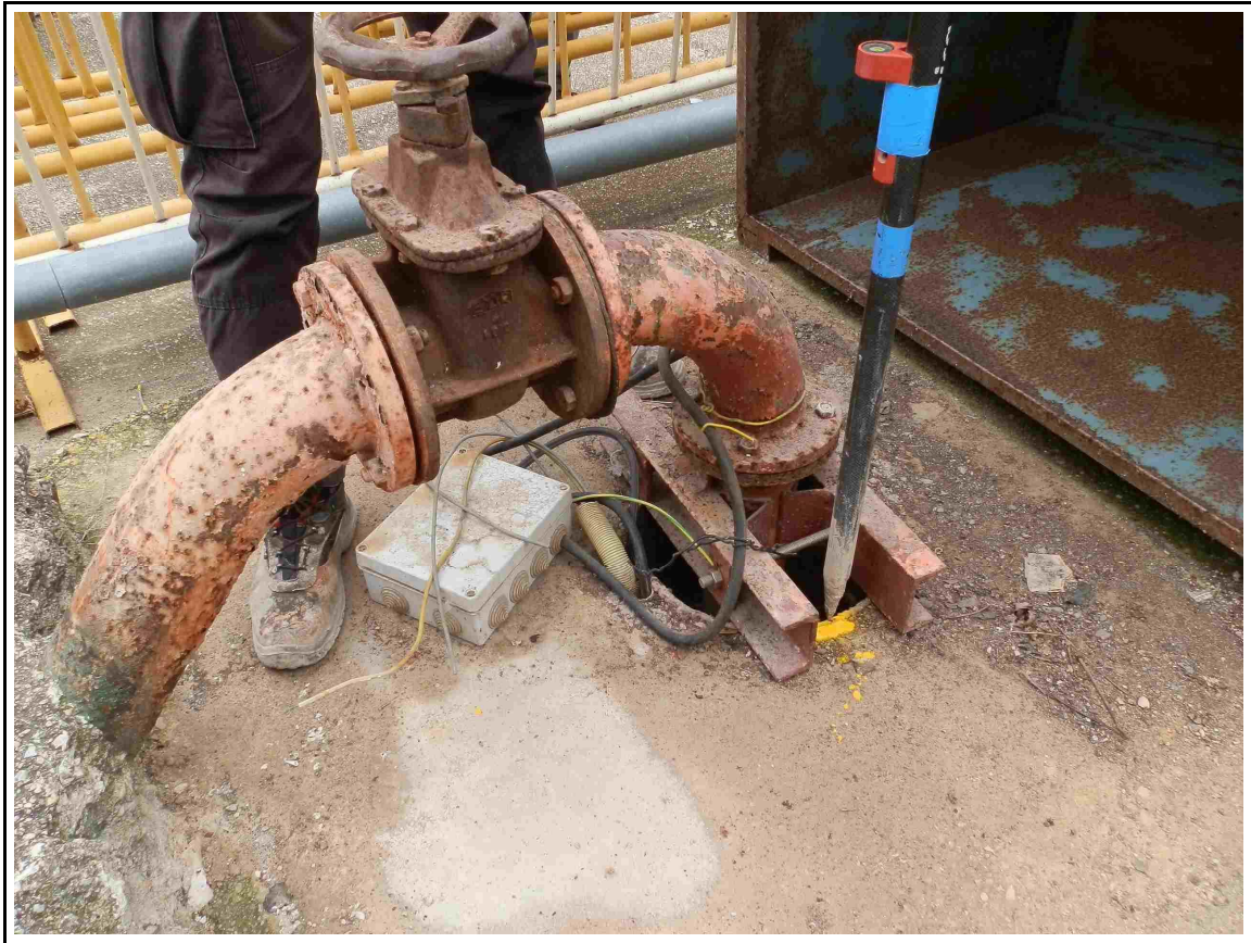
Nivelación y referencia de medida (22/11/2012)
