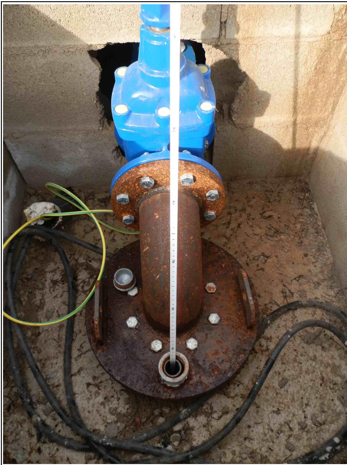
Vista de detalle (21/11/2012)
