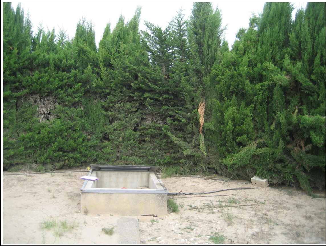
Arqueta del pozo Sorts (09/07/2008)
