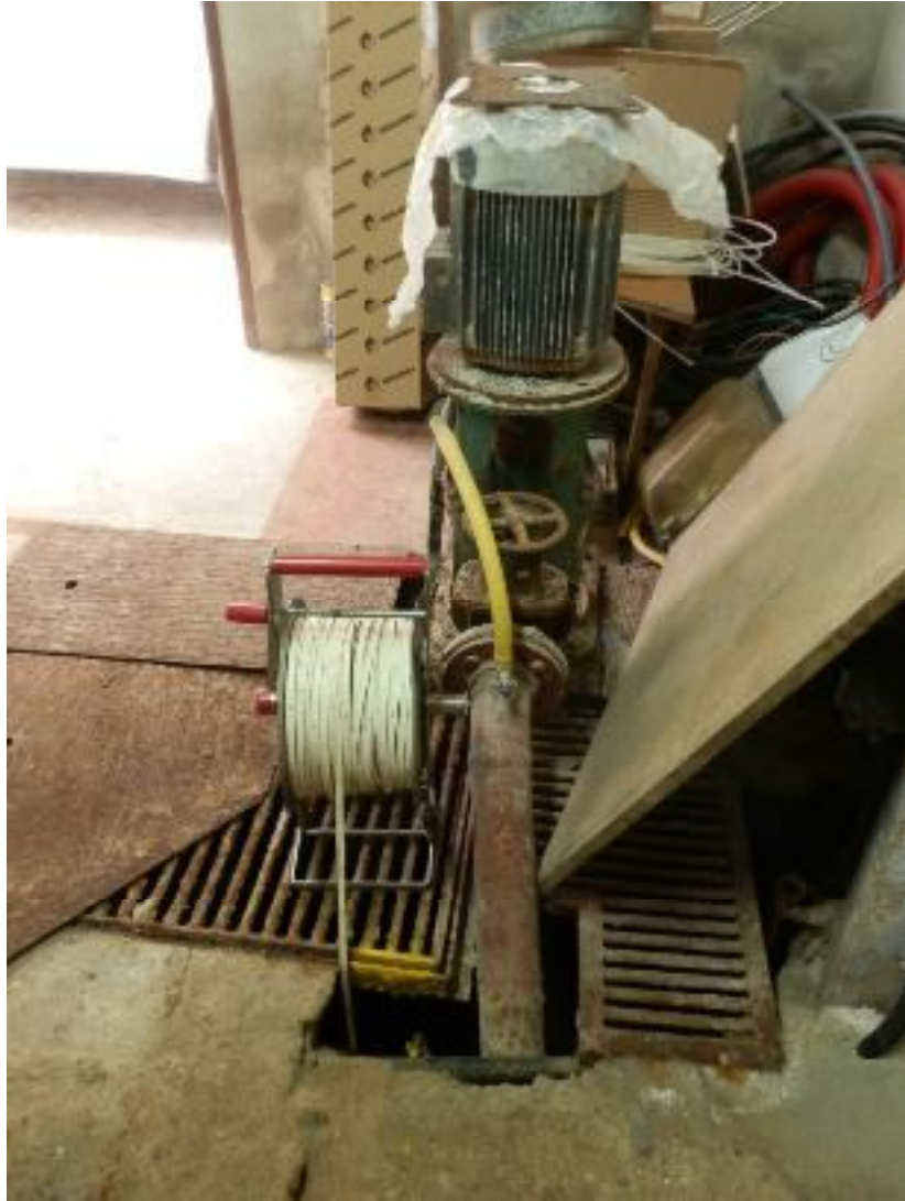
Foto 2. Nivelación pozo 3 Aldover
