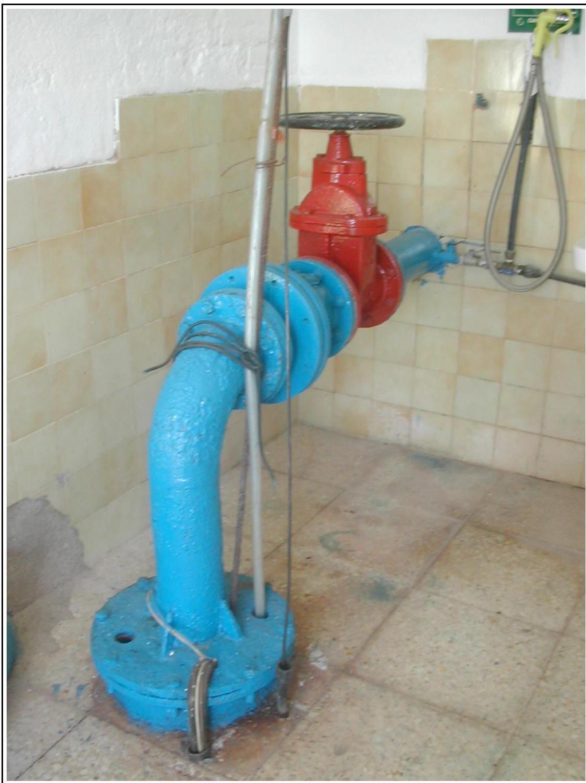
Vista del pozo (14/11/2006)
