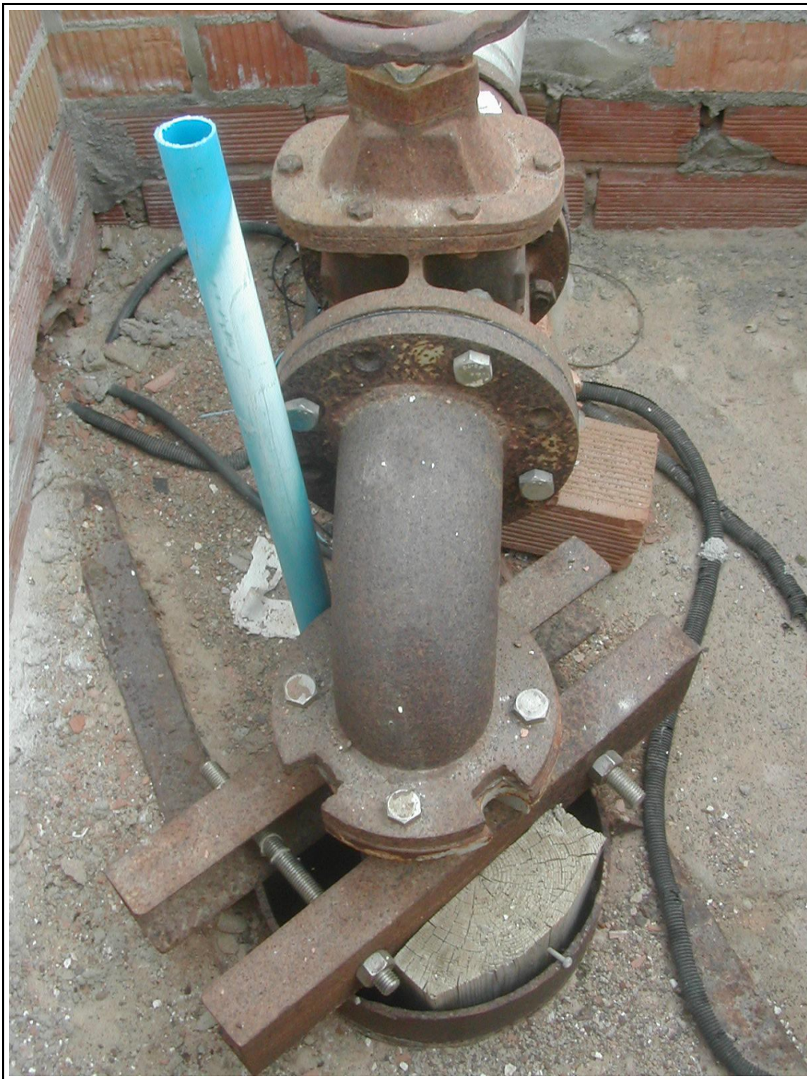
Vista de detalle (16/11/2006)
