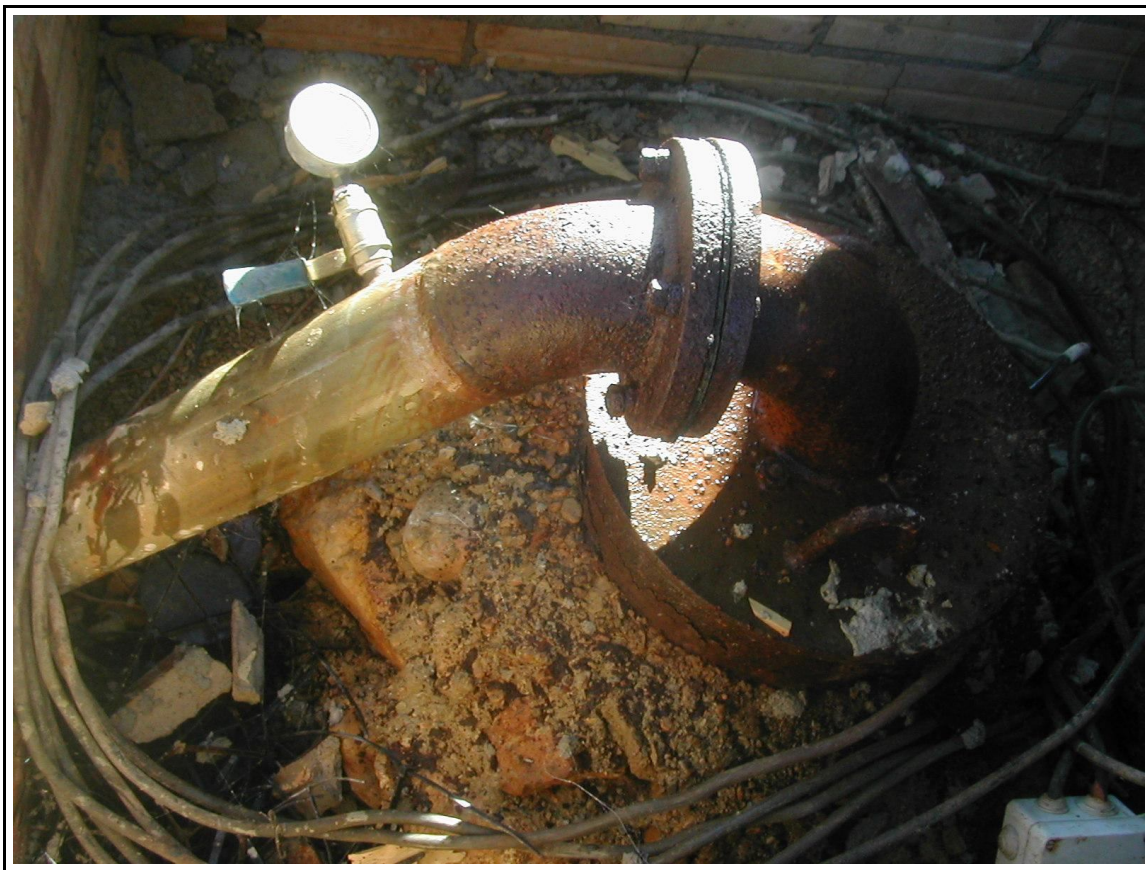
Vista de detalle 2 (14/11/2006)
