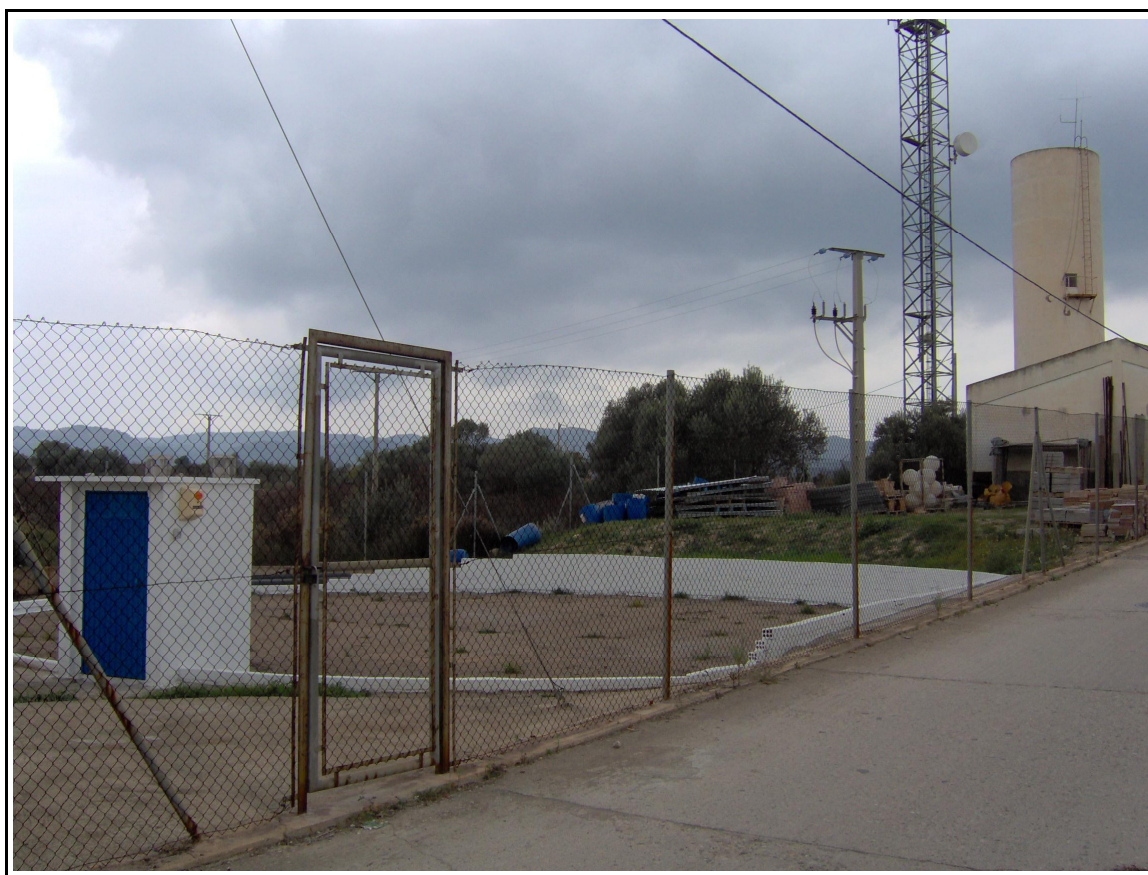
Depósito subterráneo de Mora La Nova (16/11/2006)
