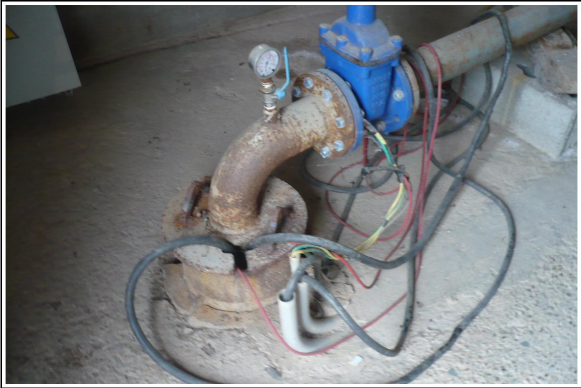
Detalle Del Pozo (03/05/2009)
