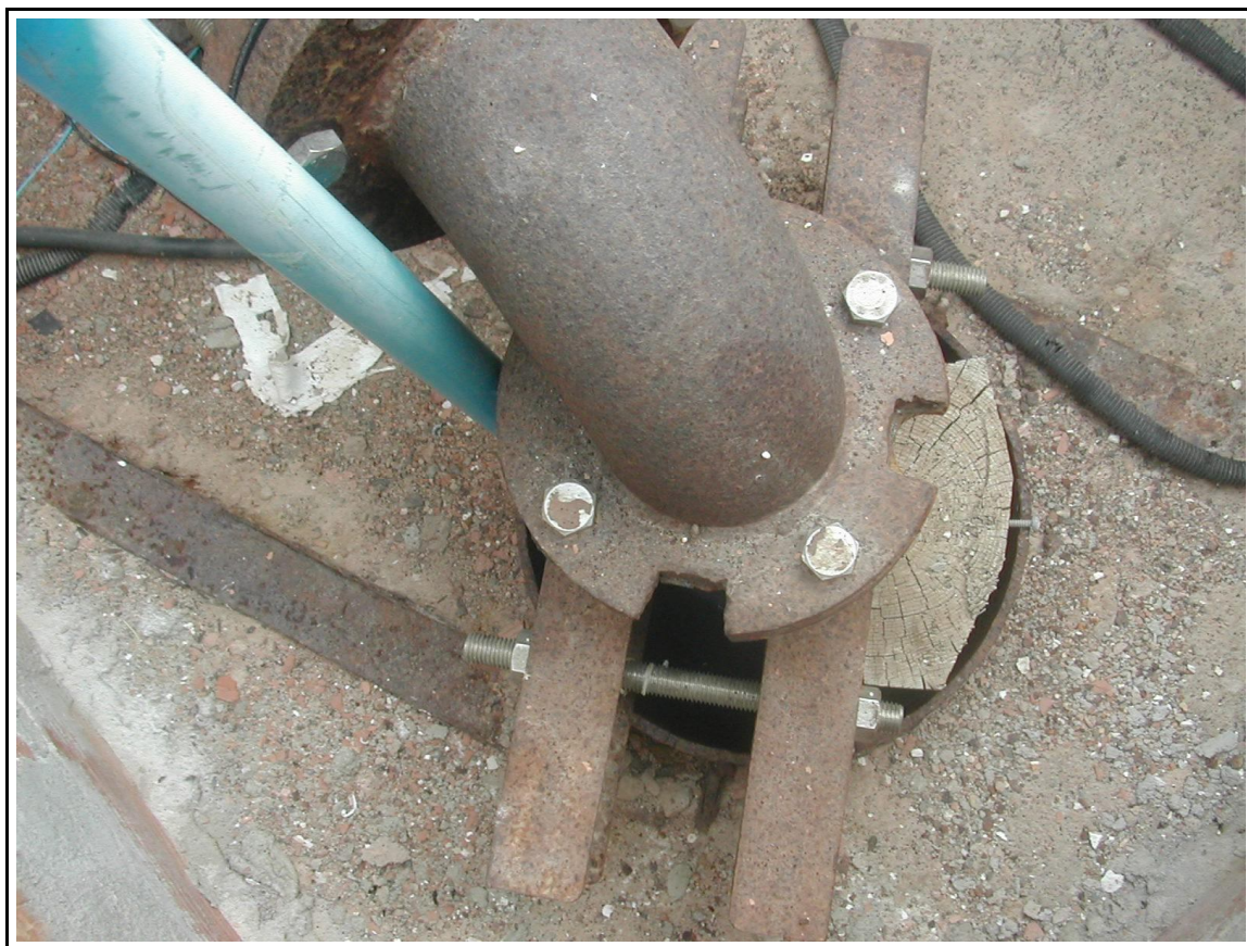
Vista de detalle 2 (16/11/2006)
