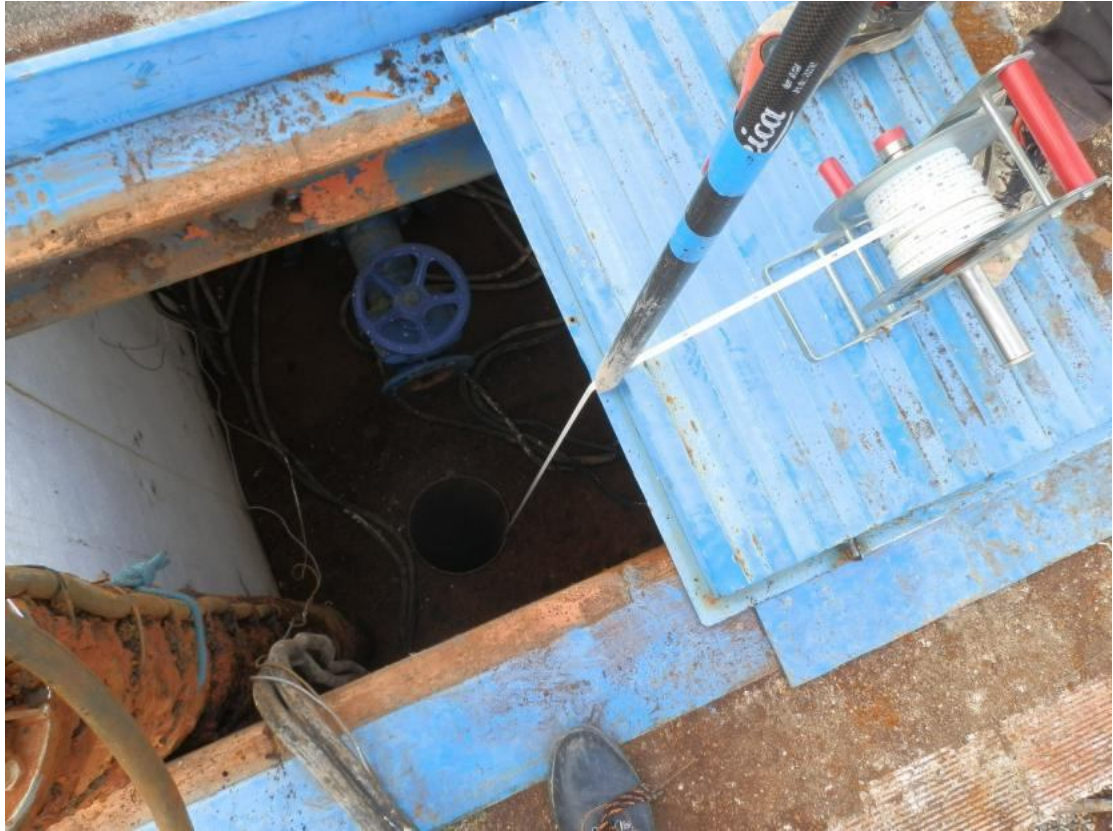
Foto 3. Nivelación referencia de medida Pozo 1 de Mora d'Ebre (observación)
