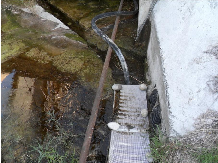
Fuente del Loro. Conjunto de drenajes que se captan bajo la arqueta para bombeo y tratamiento. Destacar la presencia del Drenaje Sur (3113-1-0151), que se corresponde con los dos tubos corrugados que salen bajo el hormigón a la derecha de la arqueta.
