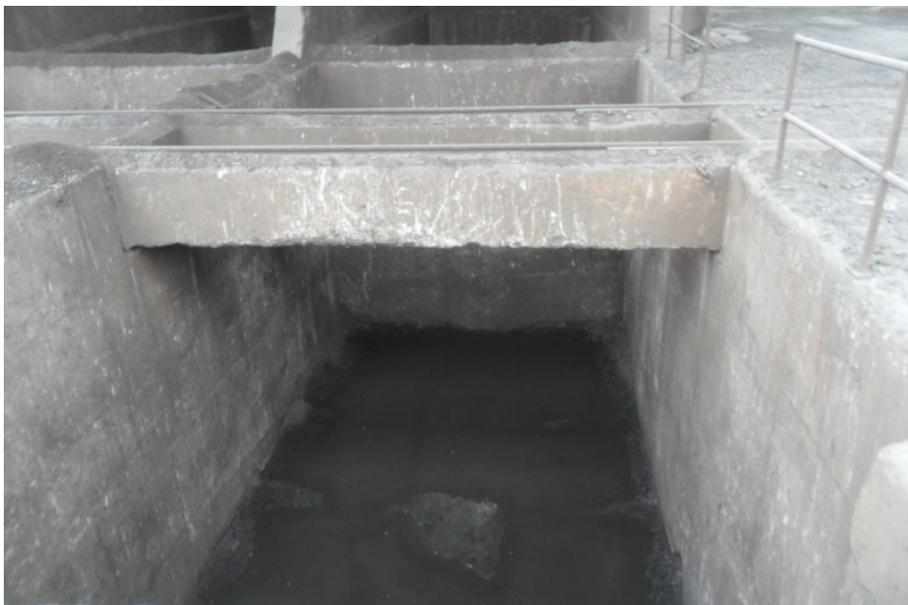
Fosos de almacenamiento de materia prima de Hidronitro. Se observa agua el nivel freático en la parte del fondo de los mismos.
