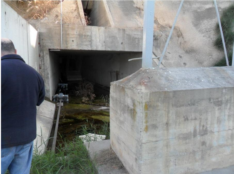
Fuente del Loro. Anclajes de la pasarela del rack de tuberías.
