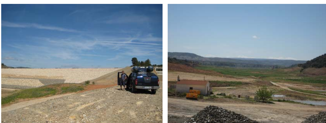
Obras en el Embalse de Lechago en el verano de 2008
