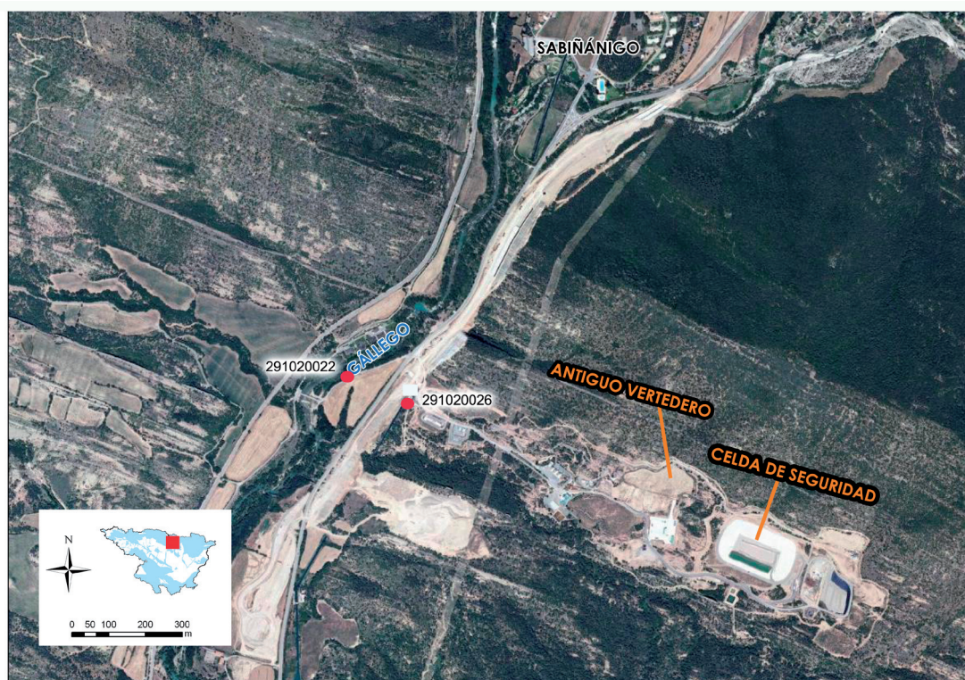
■ FIGURA 4.3.13 SITUACIÓN DE LA ZONA CONTAMINADA. ZONA 030-02
