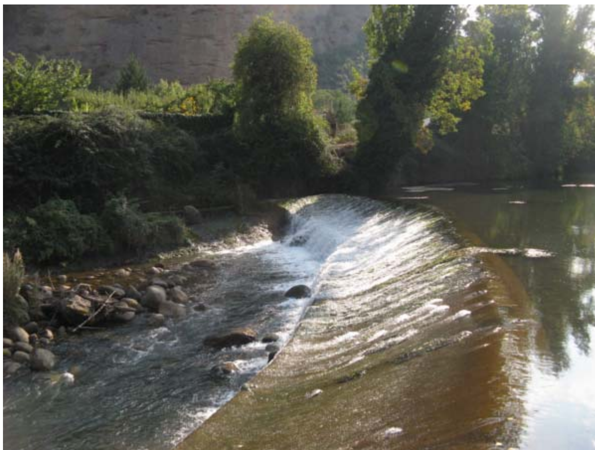
Fig. 3. Vista de la estructura desde la margen izquierda
