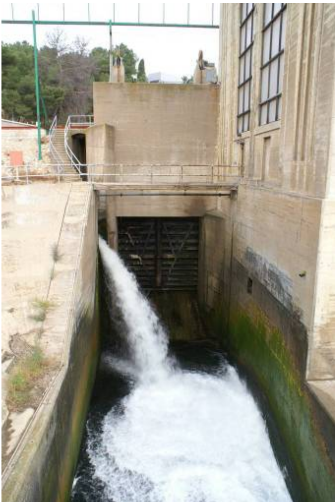
Figura 12: Central hidroeléctrica del Ebro en Flix, con un dispositivo de paso para peces sin funcionar y un canal de navegación que tampoco está operativo desde hace varios decenios.
