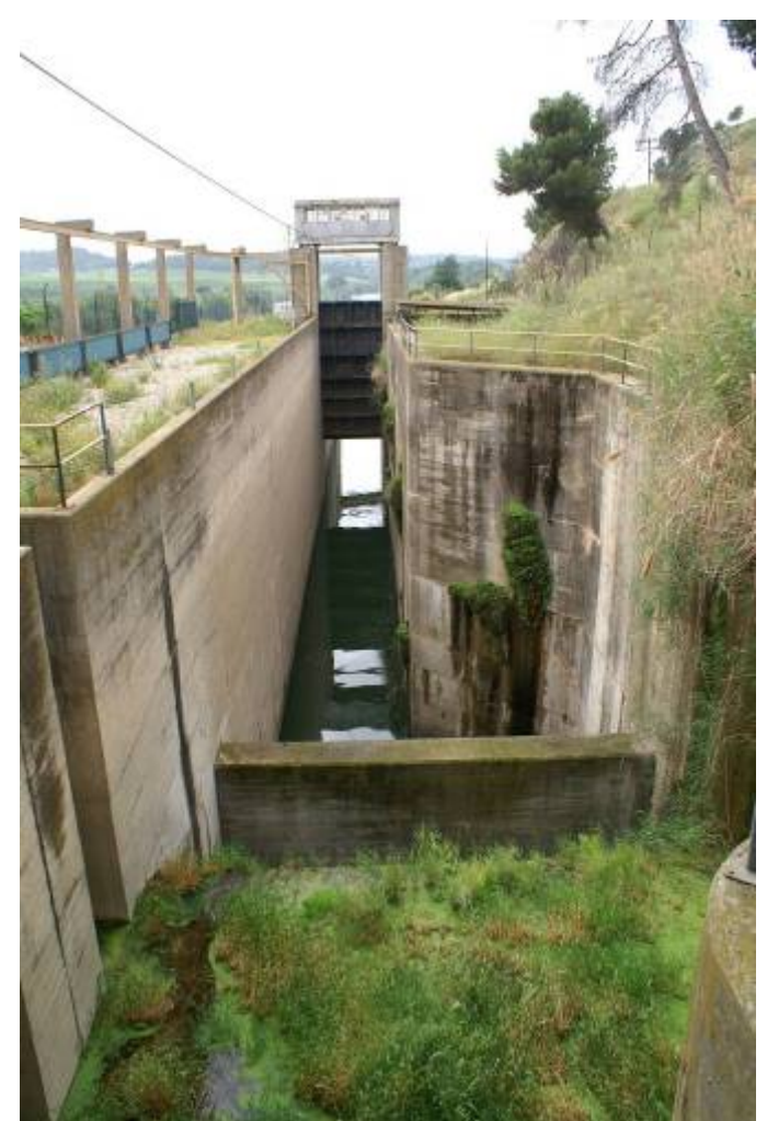
Figura 12: Central hidroeléctrica del Ebro en Flix, con un dispositivo de paso para peces sin funcionar y un canal de navegación que tampoco está operativo desde hace varios decenios.
