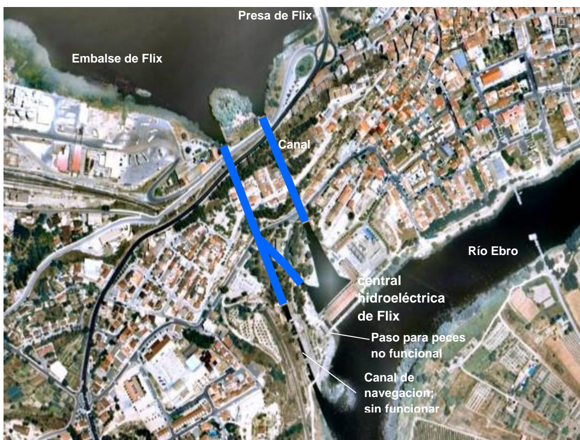
Figura 11: Central hidroeléctrica del río Ebro en Flix (Imagen de fondo: Google Earth 7/2009)
