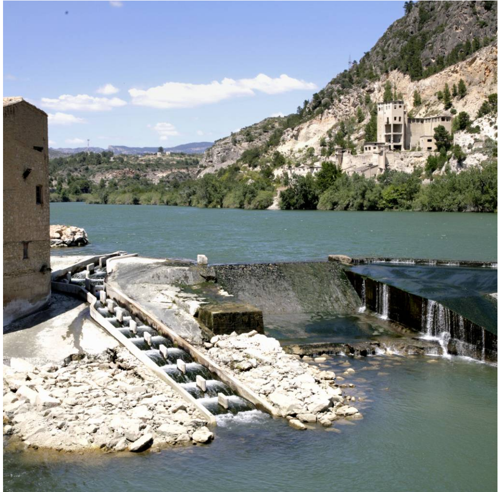
Figura 23: Dispositivo de paso para peces construido recientemente en el Azud de Xerta
