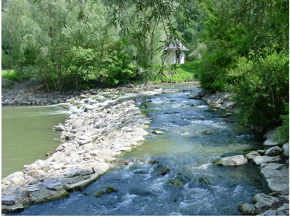
Figura 19: Ejemplo de rampa para peces de Austria
