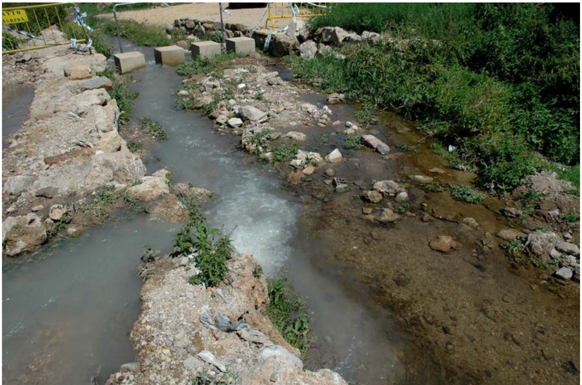
Fig. 93. Detalle de las obras en el tramo de Ágreda (Estación N° 351) en el río Val.
