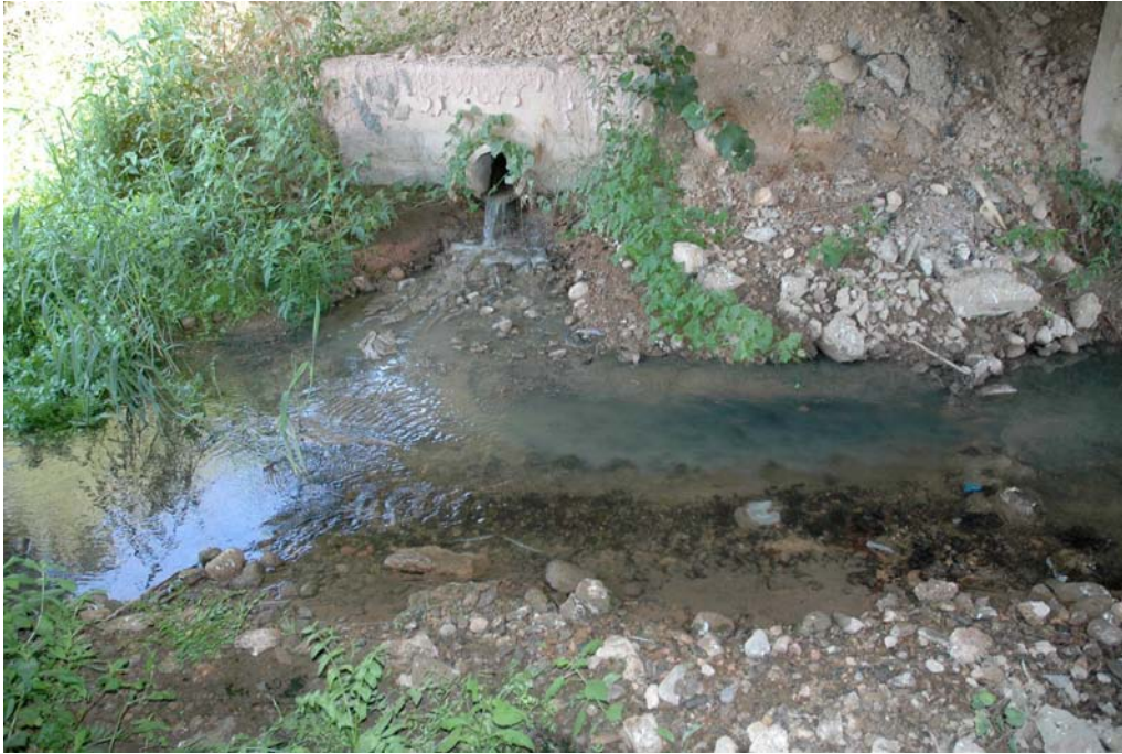
Fig. 80. Desagüe vertiendo en el tramo de Novallas (N° 252) en el río Queiles. Se observa en la mitad del río el color del agua más oscura por el vertido.
