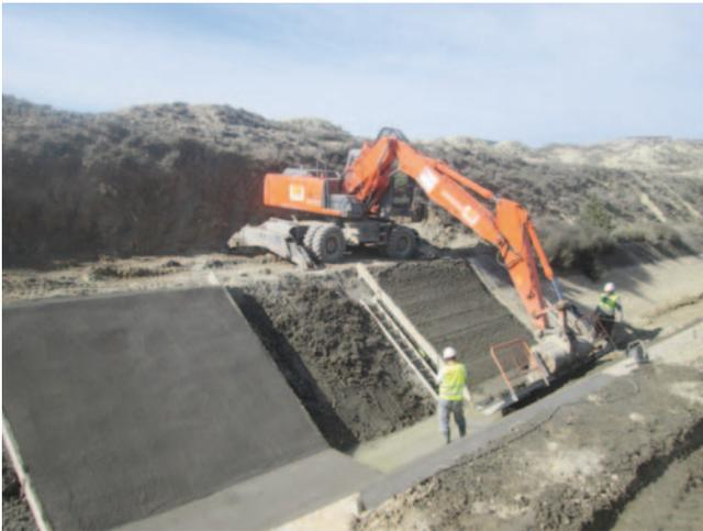
Durante el 2015 se han demolido y reconstruido 175 m de nuevos cajeros, limpiado 4.500 m de cunetas y 3.250 m de desagües y sellado además 320 m de juntas.
