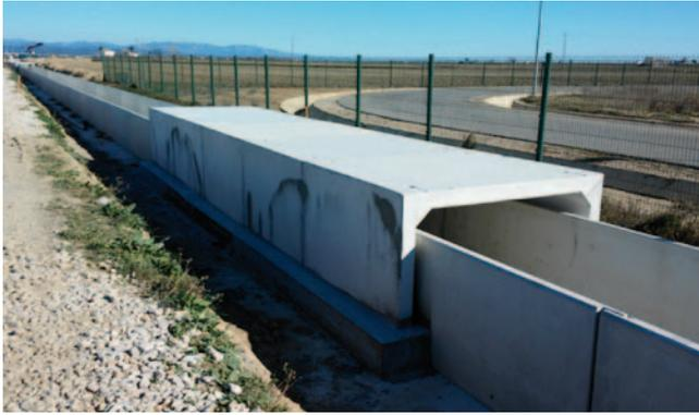
armado HA-45 con cemento SR, y sección interior de 1,6 X 1 m, que apoya sobre una capa granular rodeada de membrana geotextil. Se disponen 10 puentes de hormigón armado, de 6 m de longitud para acceso a parcelas, 2 obras de regulación de nivel y 47 tomas de riego. Se incluye la reparación del camino adosado.
