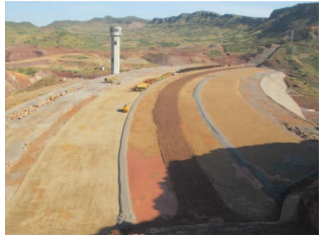
permeabilización de la presa y la pantalla de drenaje de la misma.
