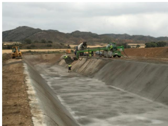
cación de un geotextil y ejecución de una nueva solera de hormigón con un espesor de 0,45 m.
