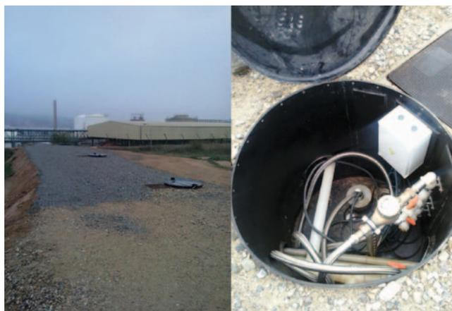
Barrera de pozos de bombero en una descontaminación de aguas subterráneas en el acuífero aluvial del Ebro en Flix (Tarragona). Vista general (izquierda) y detalle de la instrumentación de uno de los pozos (derecha).
