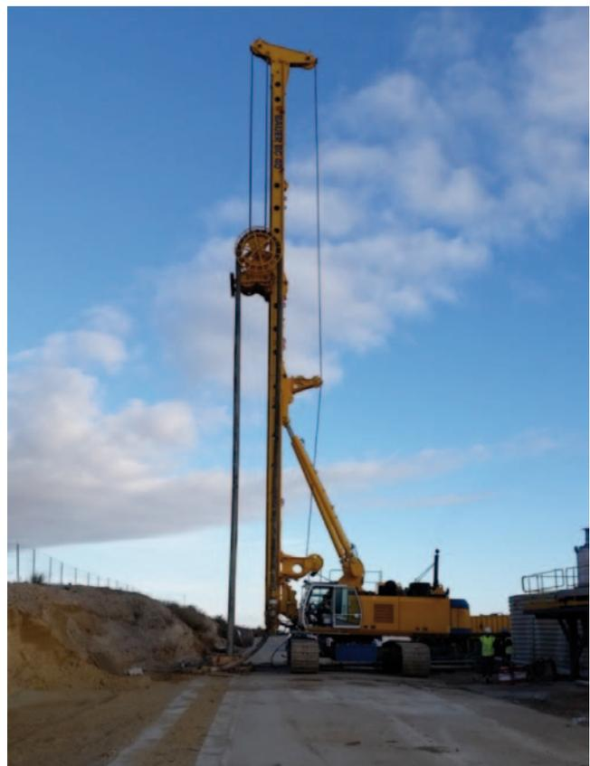
Las obras consisten en la terminación de la pantalla de impermeabilización en el estribo izquierdo de la presa con 52,10 m, espesor de 0,65 m y profundidad de 32 m. Unirá la pantalla de bentonita-cemento construida en la presa, el tapiz de aguas arriba, con la pantalla de hormigón plástico construida en 2014.
