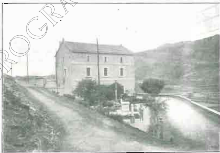
PANTANO DE PENA. Casa de oficinas.
