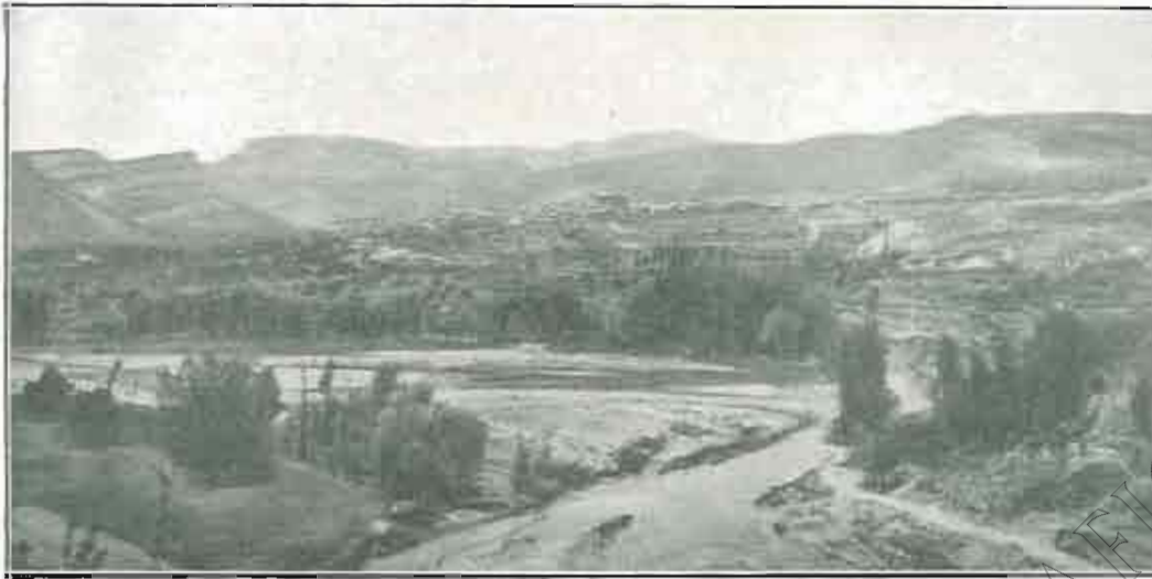
PANTANO DE SANTOLEA. El caserío visto desde aguas abajo.
