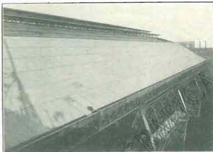
Detalle de la nueva estación de R. T. S. en Barcelona, techada con placas GNHLETA
