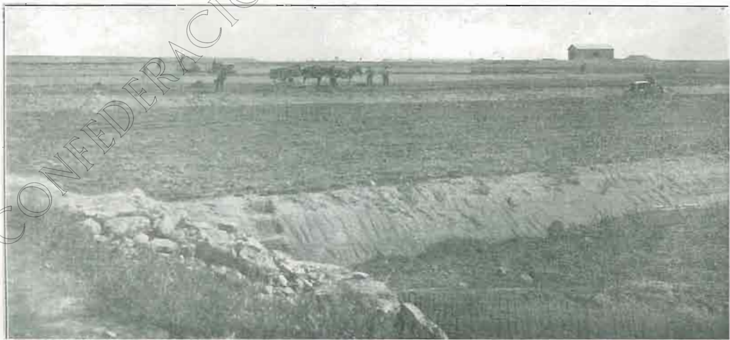
TRABAJOS DE NIVELACIÓN DE TIERRAS, realizados en el Centro Agronómico de Almodóvar.
