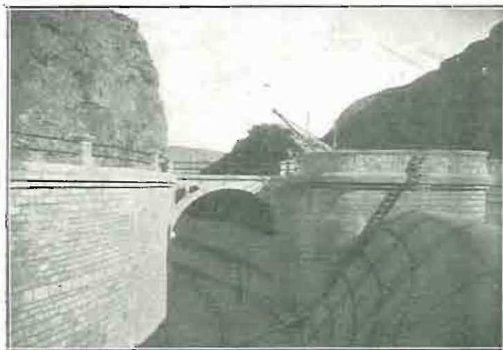
PANTANO DE CUEVA FORADADA. Embocadura del canal aliviadero de superficie.
