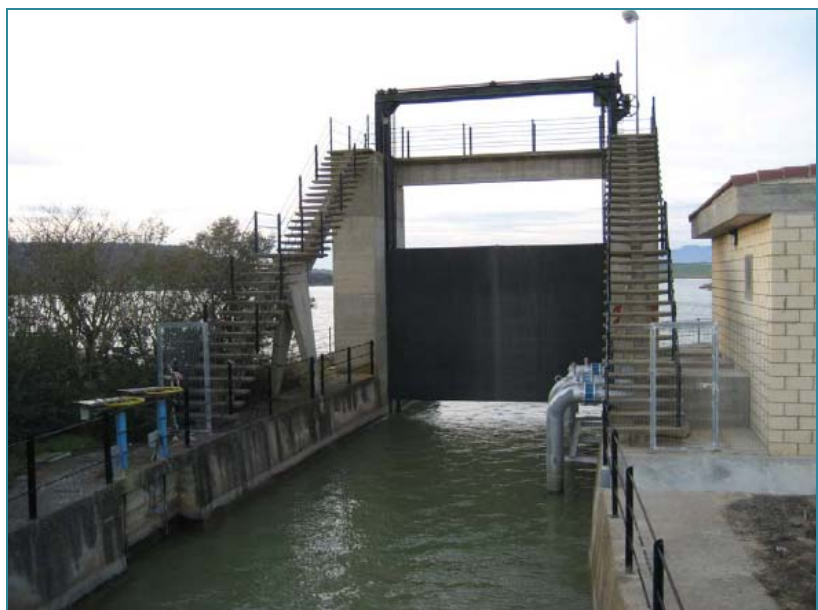
Embalse de Valdabrá: detalle de la entrada del Canal del Cinca
