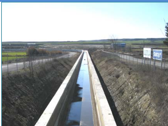
Acequia de La Violada, recientemente modernizada en su totalidad
