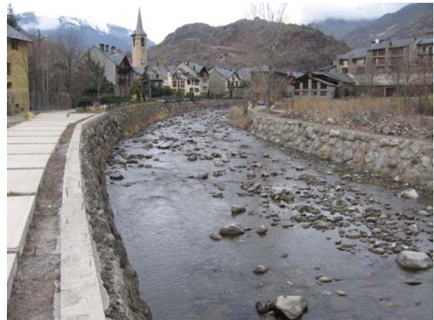
Encauzamiento del río Noguera-Pallaresa en Esterri d'Aneu
