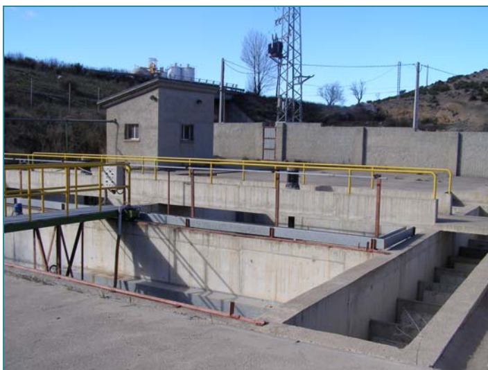
Depuradora del polígono industrial La Estación, en Andorra (Teruel)
