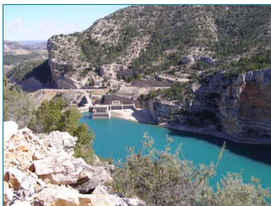
Presa de Santolea
