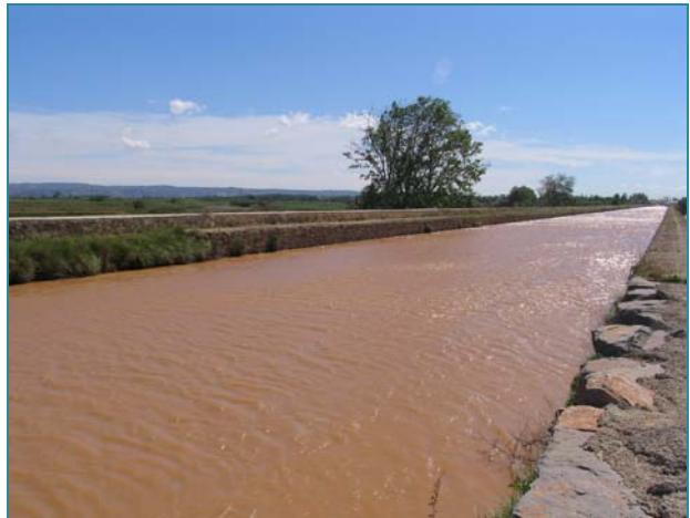
Canal Imperial de Aragón en las proximidades del río Jalón
