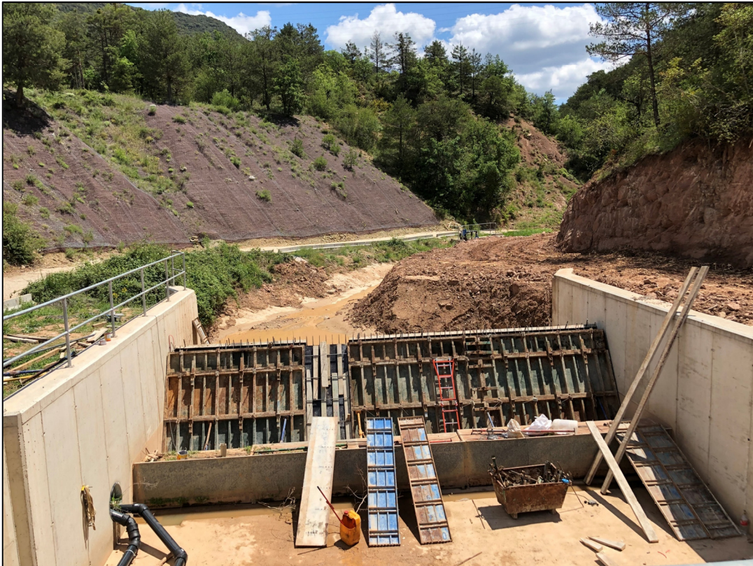
By-pass en el barranco de Bailín (Sabiñánigo) (19/6/2019)
