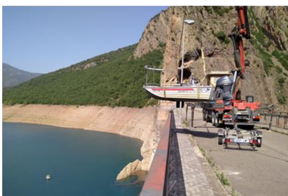
Acceso embarcación con grúa
