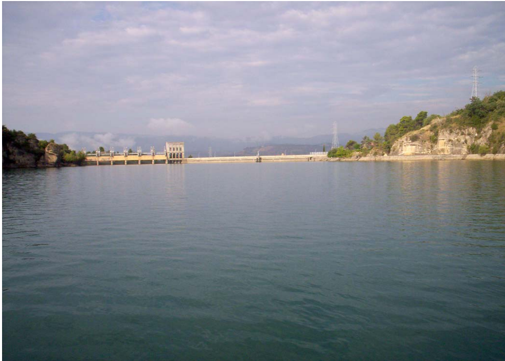
Vista de la presa desde la estación de muestreo (E1). Verano de 2004 (04/08/2004)
