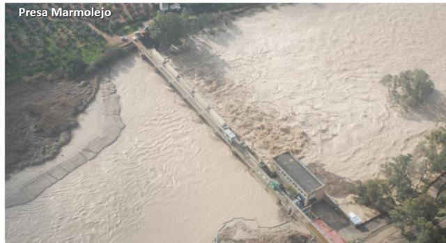
El embalse recibe una aportación media anual de 914 Hm<sup>3</sup> de una cuenca hidrográfica de 21.080 Km<sup>2</sup> de superficie. Tiene una capacidad total de 13 Hm<sup>3</sup> y una superficie de 2,92 Km<sup>2</sup>. La explotación del embalse se efectúa con una oscilación de lámina de 0,9 m por debajo de la cota máxima 191,80 m.s.n.m.
