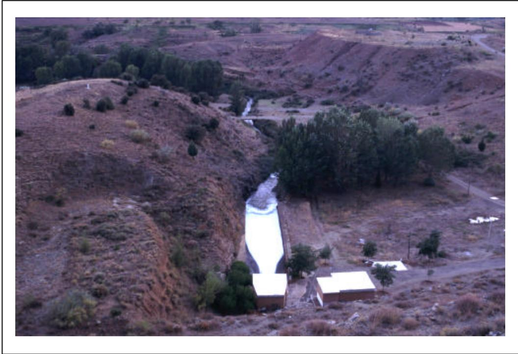
Foto 3. Vertido en el río Aranda por la válvula de chorro hueco.
