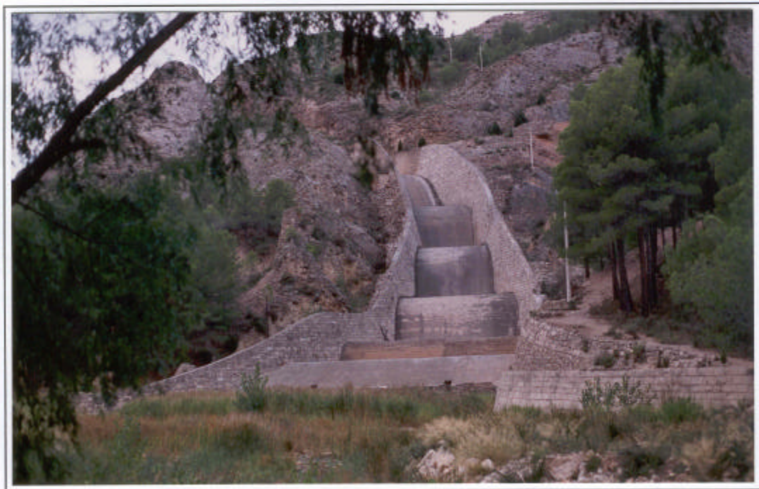
Detalle del aliviadero.
