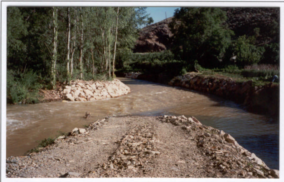
Río Piedra inmediatamente aguas abajo de la presa.
