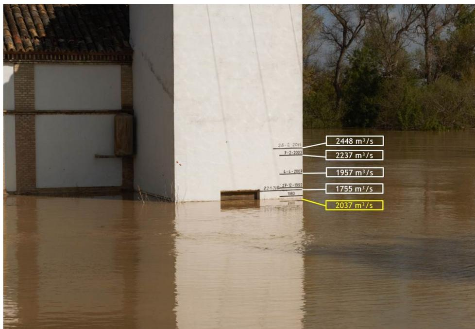
Figura 3: Nivel alcanzado en Boquiñeñi durante la avenida de 2018. Las actuaciones llevadas a cabo han supuesto una mejora significativa de la capacidad de desagüe del cauce.
