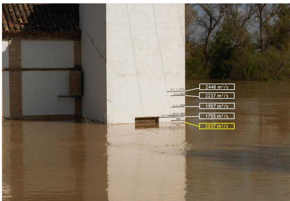
Figura 2: Nivel alcanzado en Boquiñeni durante la avenida de 2018. Las actuaciones llevadas a cabo han supuesto una mejora significativa de la capacidad de desagüe del cauce.
