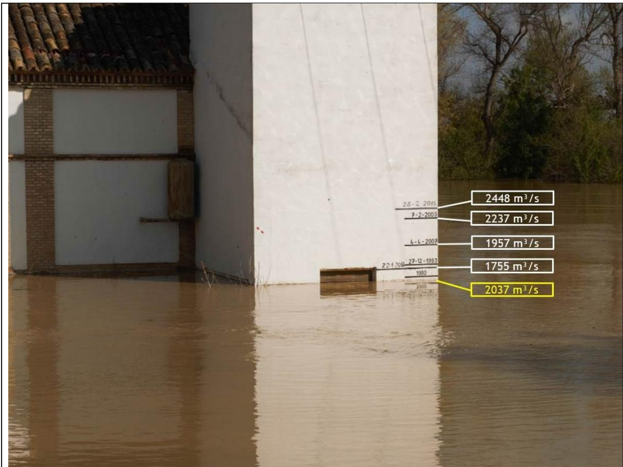
Figura 1: Nivel alcanzado en Boquiñeni durante la avenida de 2018. Las actuaciones llevadas a cabo han supuesto una mejora significativa de la capacidad de desagüe del cauce.
